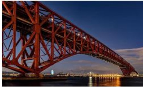
Figura 1.14.-Redundancia en un puente. Tomada de: DMCA (2023)
