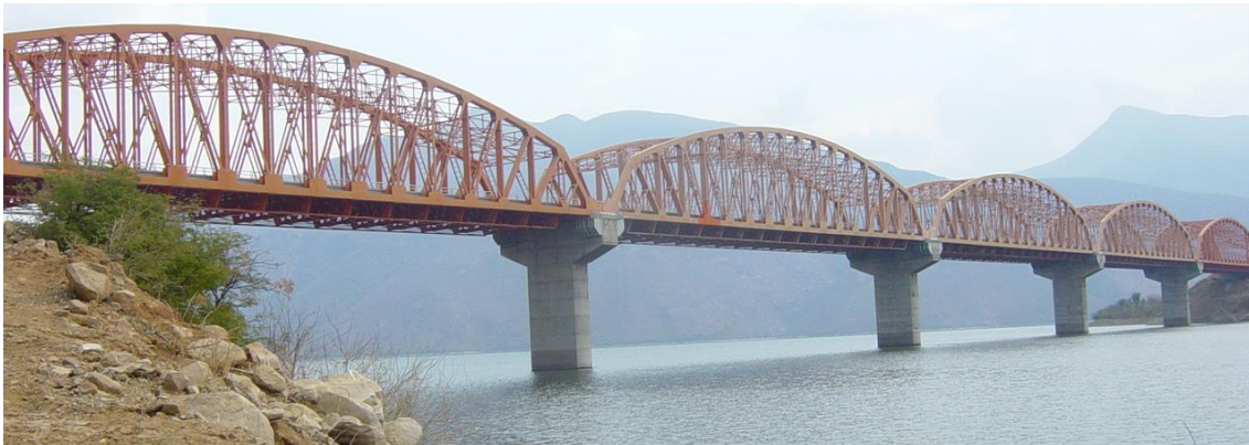
Figura 3.14.-Puente el Infiernillo II
