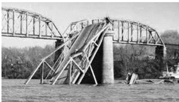
Figura 1.10.-Falla por fractura. Tomada de: Polimeni (2023)
