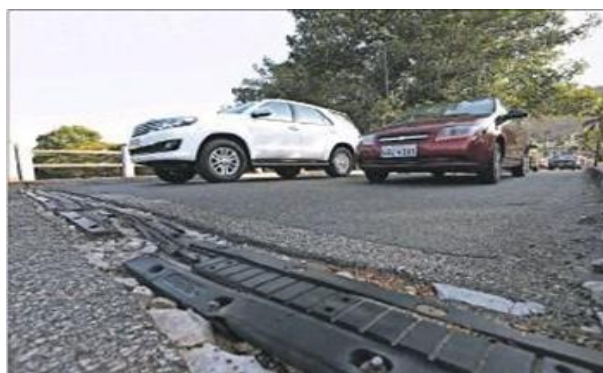
Figura 1.19.-Desgaste de las juntas de expansión. Tomada de: Expreso (2018)
