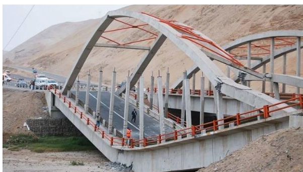
Figura 1.9.-Falla por fatiga. Tomada de: C. (2015)
