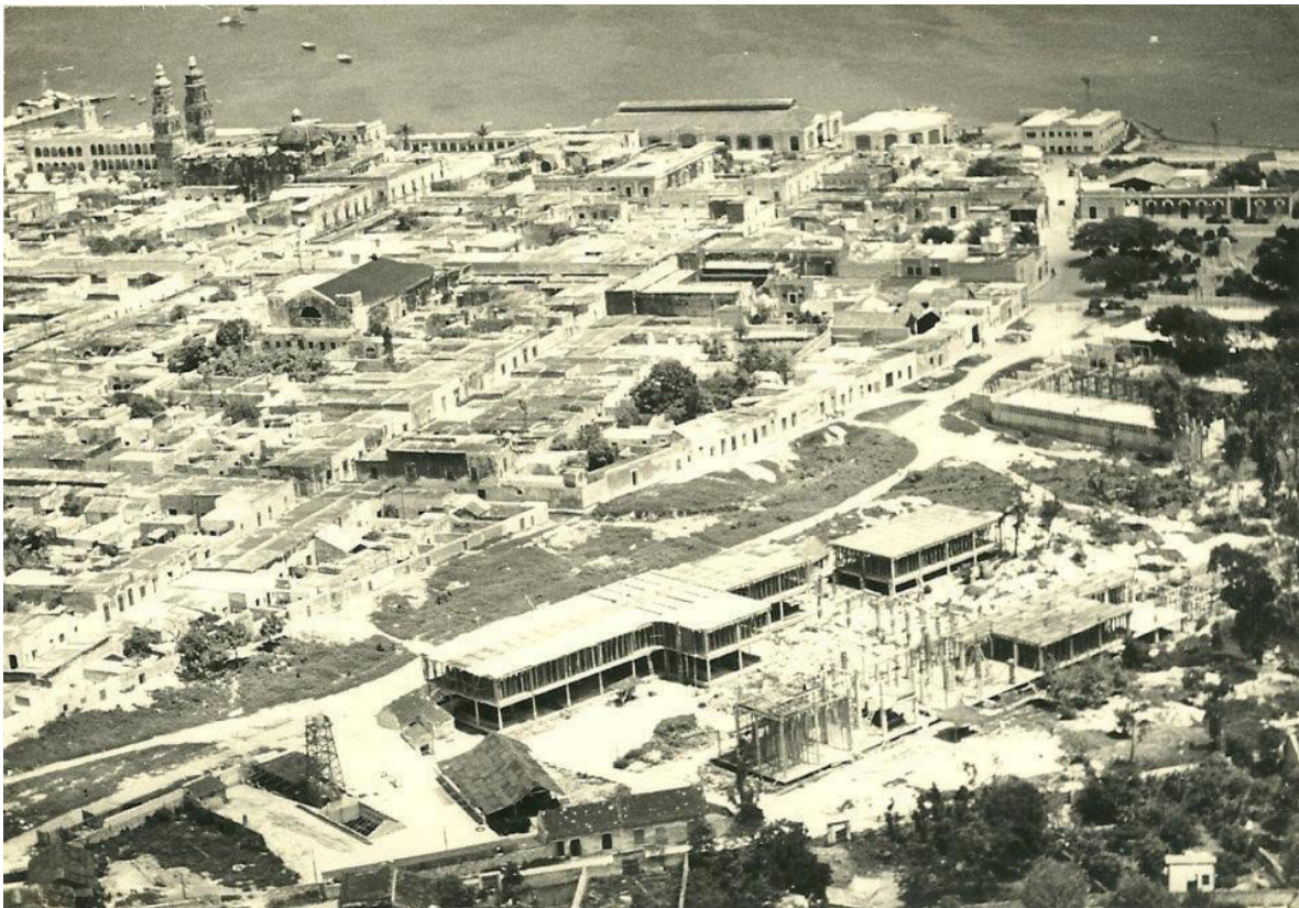
Imagen 32. Construcción del Hospital General.
