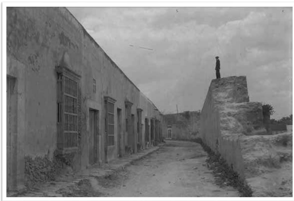
Imagen 7. Destrucción del lienzo de muralla y casas en estado de abandono.
