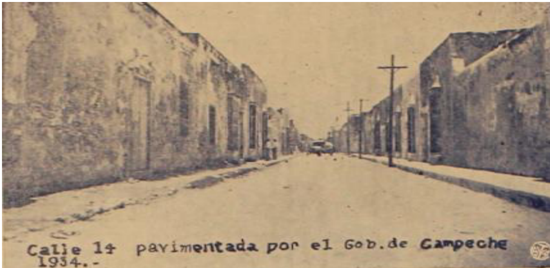
Imagen 16. Pavimentación de la calle 14, una obra gubernamental prioritaria en 1934.
