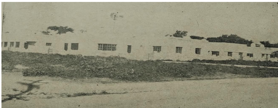
Imagen 29. Casas en construcción para obreros en la ciudad de Campeche
