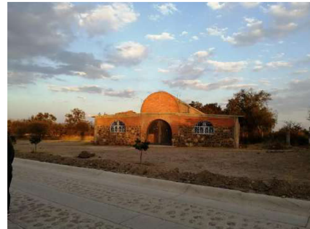
Figura 70. Vista de la fachada de la capilla
