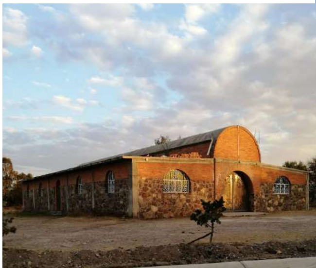
Figura 71. Vista de la fachada de la capilla
