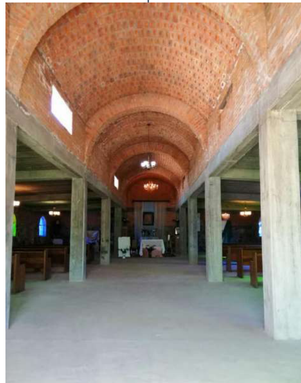
Figura 68 vista interior de los arcos de la capilla
