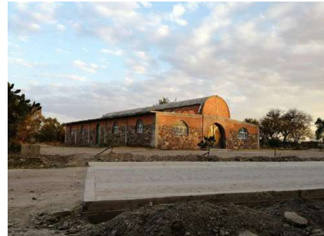
Figura 69. Vista de la fachada de la capilla
