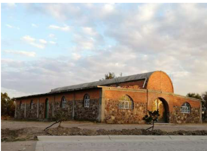
Figura 71. Vista de la fachada de la capilla
