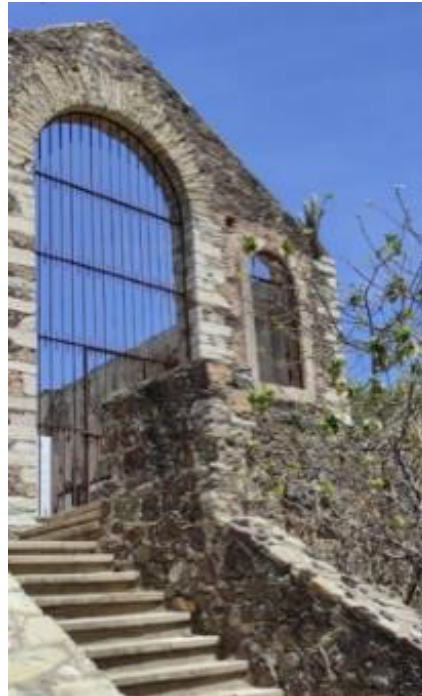
Figura. Edificio para el malacate de vapor en Mineral de San Juan de Rayas, elaboración propia.
