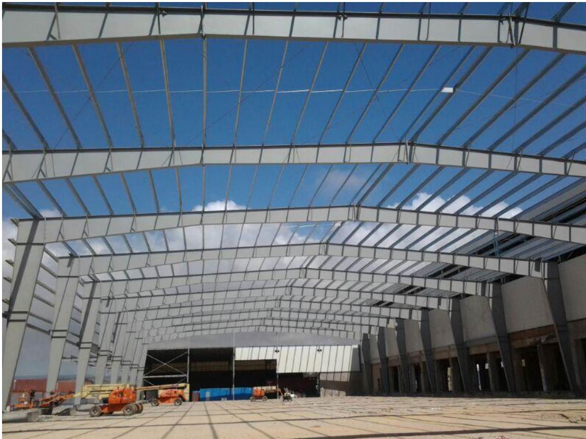
Figura 1 Sistema de marcos para nave industrial.
