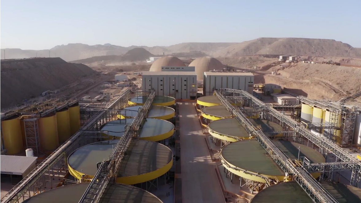
Imagen 7. Plantas de lixiviación dinámica, PLD 1 a la derecha y PLD2 del lado izquierdo, en el centro el sistema de lavado contra corriente, en los costados los reactores, en el fondo la zona de trituración seguida de los domos del stock de finos y las naves del circuito de molienda.
