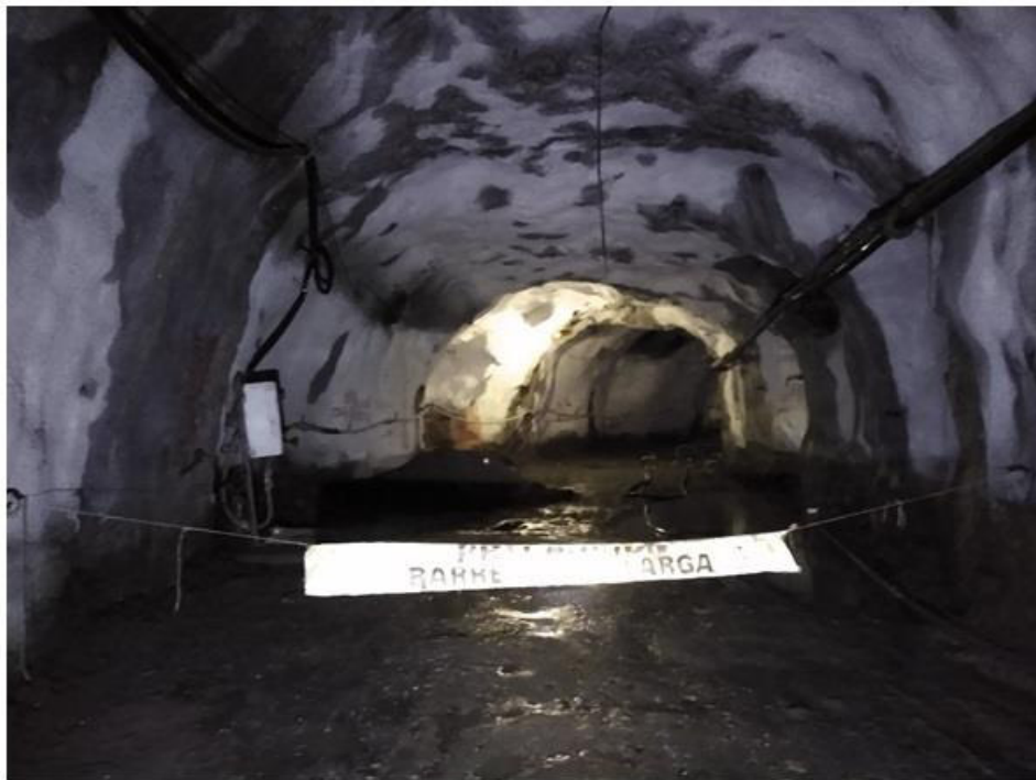
Figura 17. Nivel de barrenación listo para ser explotado
