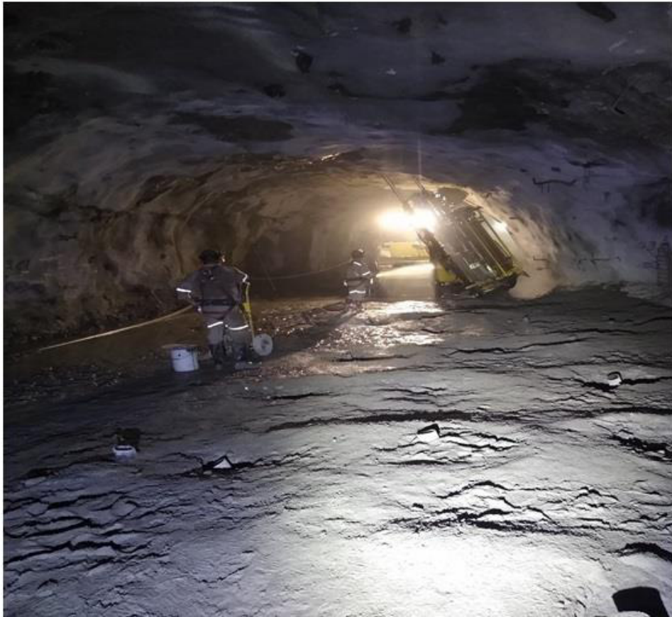
Figura 21. Barrenación en línea.
