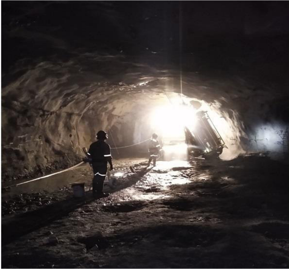
Figura 20. Rebaje en explotación con Simba M4 - C
