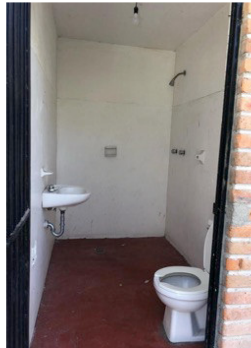
Fotografía 1. Baño exterior, planta baja.
