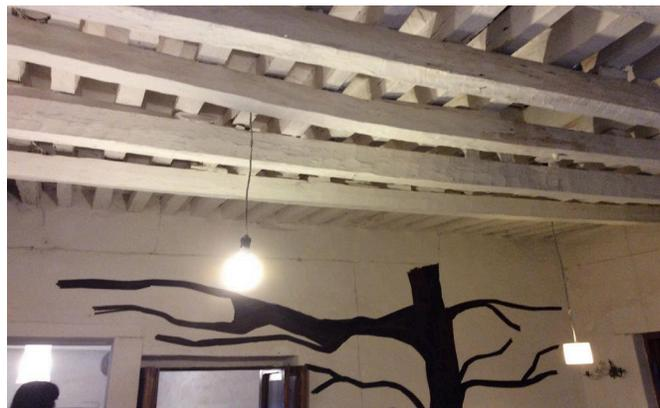
**IMAGEN 3: Losa con viguería de madera.**
