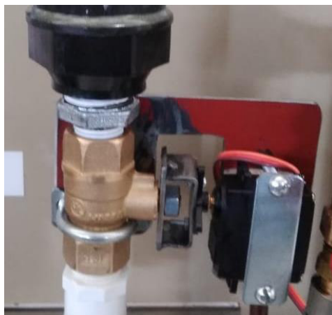
Figura 3.29. Montaje de servomotor a la válvula de paso.
