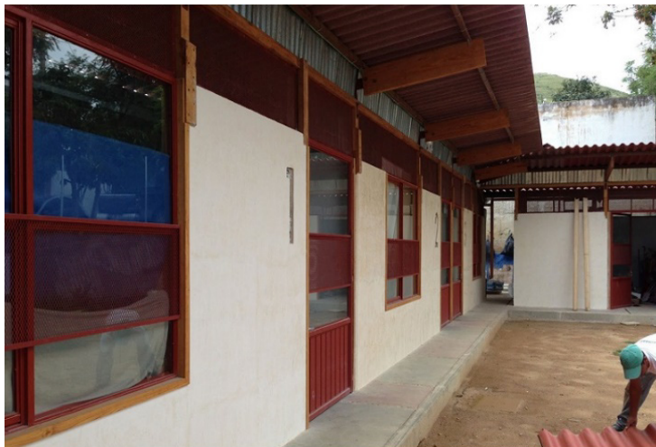
Imagen 19. Muro con acabado final.
