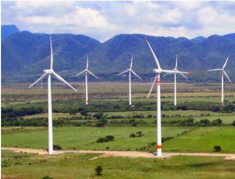
Figura 1: Aerogenerador de tres palas de eje horizontal
