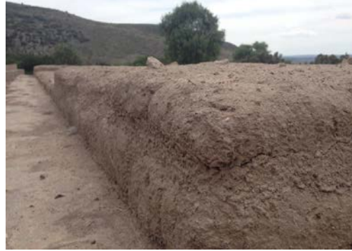
IMAGEN 4 Podemos ver en la imagen el claro uso de los adobes con mortero de lodo o arcilla en la zona arqueológica del Cópore.
