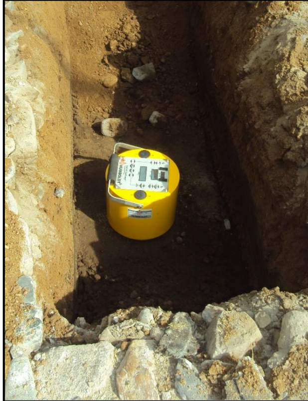
Vista de realización de prueba Geo-gauge PCA #1
