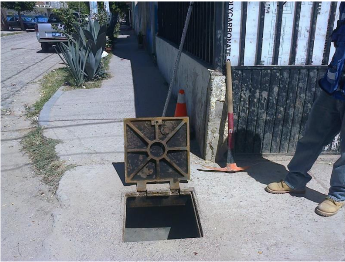
Obtención de información en campo de las instalaciones existente dentro tramo a intervenir
