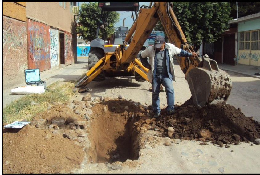
Vista de Realización de PCA #1
