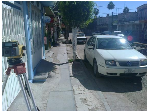
Nivelación de puntos de control
