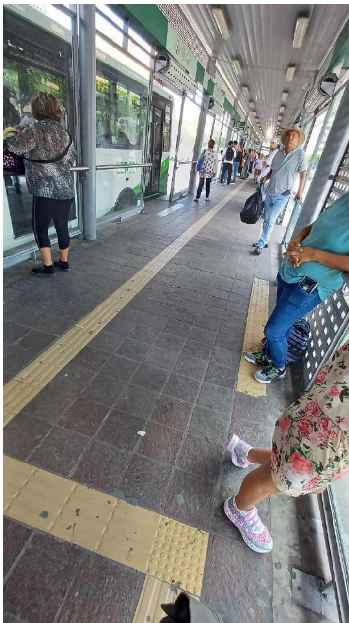
Fotografía 40. Bahía en el interior de las instalaciones de la estación intermedia de transferencia “Hermanos Aldama”. Autoria propia (2024).
