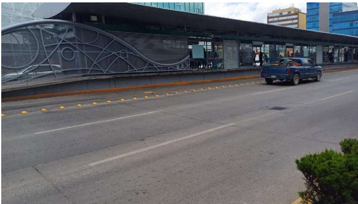
Fotografía 42. Estación intermedia de transferencia “Centro Histórico”, vista desde la acera del Blvd. Adolfo López Mateos. Autoría propia (2024).
