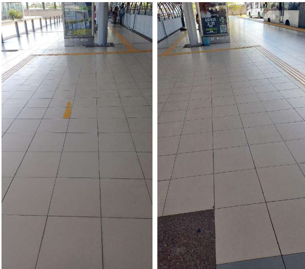
Fotografía 64 y 65. Cambio de dirección en la guía de paneles podotáctiles en el Anden A, que conecta con el tunel que comunica con la salida y el Anden B de la terminal de transferencia “San Jerónimo”, en la bahía de ascenso y descenso para las rutas alimentadoras y auxiliares (izquierda) y en la bahía de ascenso y descenso para las rutas troncales (derecha). Autoría propia (2024).
