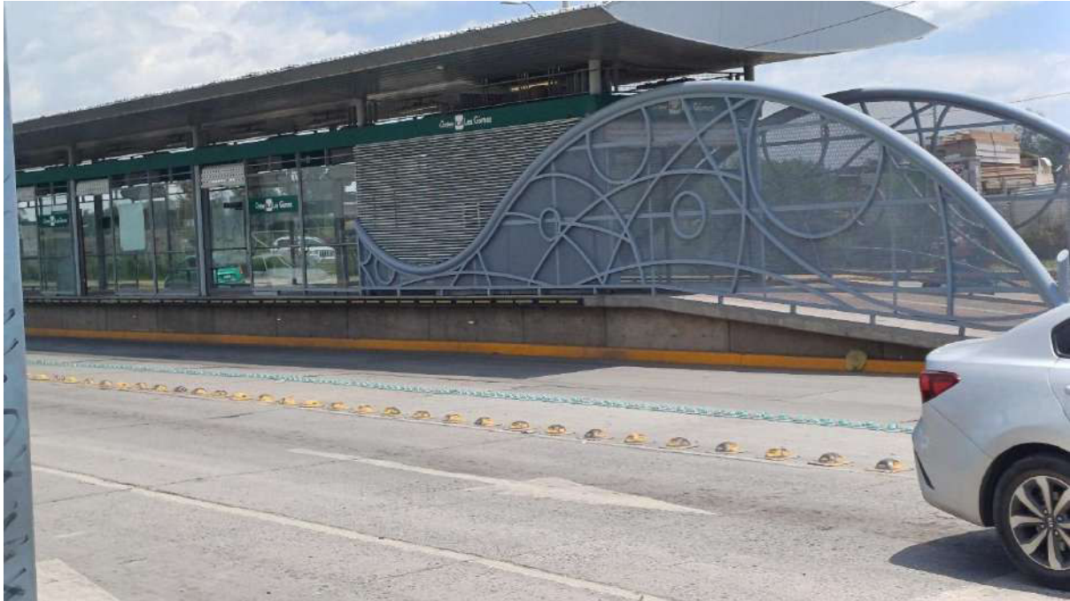
Fotografía 57. Estación intermedia “Los Gómez”, vista desde la acera del Blvd. Campestre. Autoria propia (2024).
