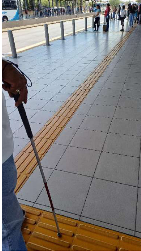
Fotografía 96. José Luis caminando sobre la guía podotáctil en Terminal de Transferencia “Delta”, al fondo otros usuarios pisando la guía. Autoría propia (2024).
