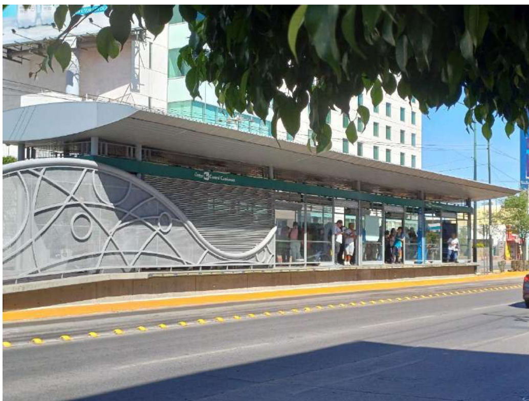
Fotografía 27. Estación intermedia “Central Camionera”, vista desde la acera en el Blvd. Adolfo López Mateos. Autoría propia (2024).
