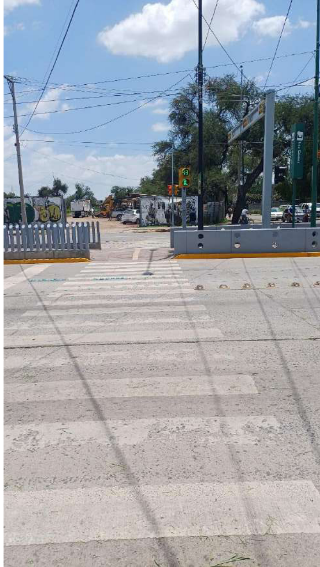
Fotografía 59. Cruce peatonal que conecta la acera del Blvd. Campestre con el camellón de acceso a la estación intermedia “Insurgentes”. Autoria propia (2024).
