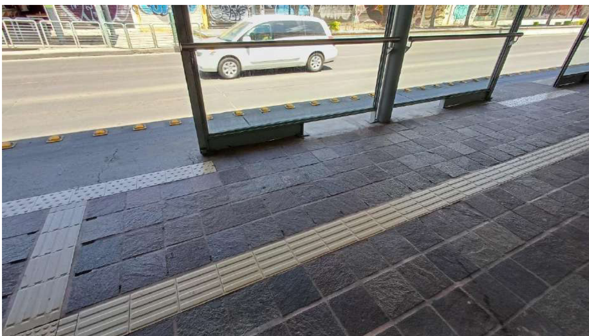
Fotografía 52. Bahía en el interior de las instalaciones de la estación intermedia “IMSS T1”. Autoria propia (2024).
