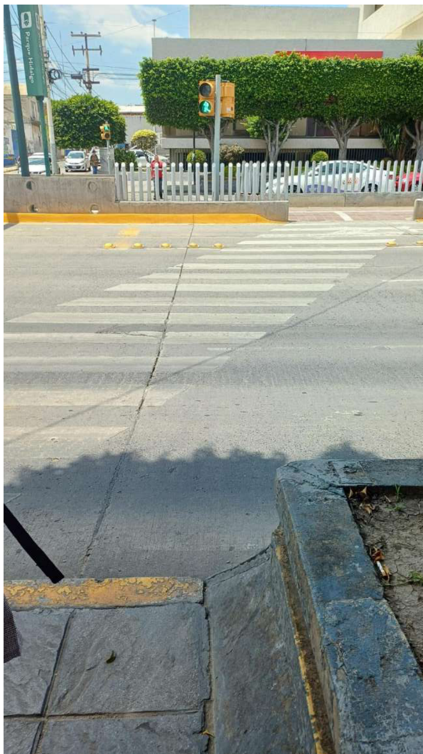
Fotografía 50. Cruce peatonal que conecta la acera del Blvd. Adolfo López Mateos con el camellón de acceso a la estación intermedia “Parque Hidalgo”. Autoría propia (2024).
