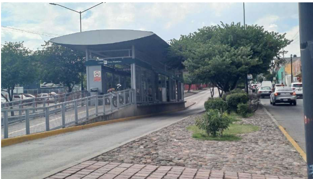
Fotografía 82 y 83. Estación intermedia “Santander” (superior) y la estación intermedia “Vista Hermosa” (inferior), ambas vistas desde la acera del Blvd. San Juan Bosco. Autoría propia (2024).
