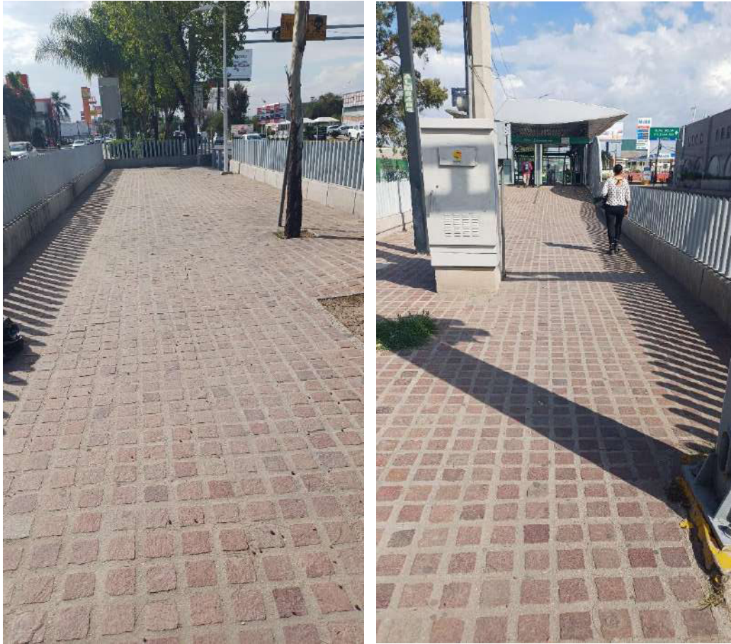
Fotografía 8 y 9. Camellón de acceso a la estación intermedia “Cerrito de Jérez”, visto desde la entrada/salida de la estación hacia la conexión al cruce peatonal (izquierda), y visto desde la conexión del cruce peatonal al camellón hacia la estación (derecha). Autoria propia (2024).
