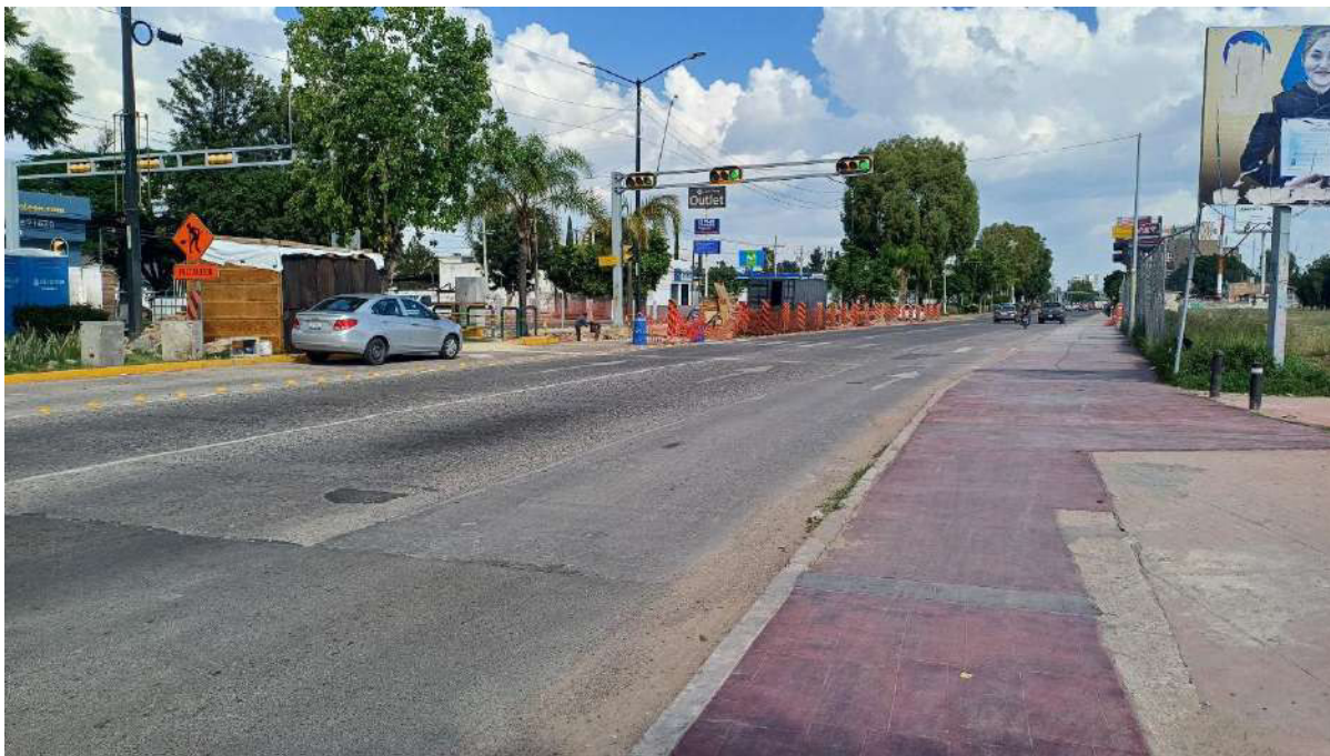
Fotografía 22. Blvd. Adolfo López Mateos a la altura donde se encontraba la estación intermedia “Bugambilias”, tentativamente en obras de renovación de la estación y sus infraestructura. Autoría propia (2024).
