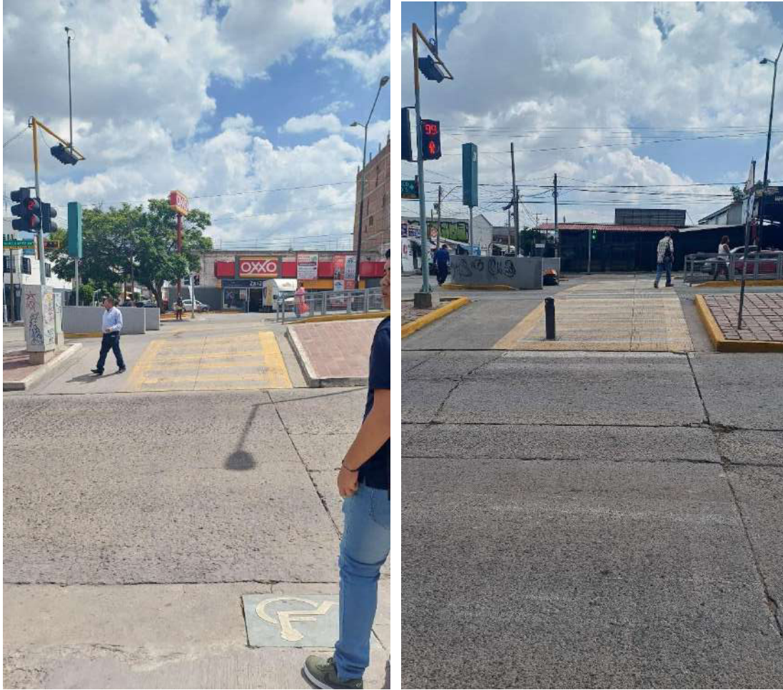
Fotografía 88 y 89. Cruce peatonal que conecta la acera del Blvd. San Juan Bosco con el camellón de acceso a la estación intermedia “Santander” (izquierda) y el cruce peatonal que conecta la acera del Blvd. San Juan Bosco con el camellón de acceso a la estación intermedia “Vista Hermosa” (derecha). Autoria propia (2024).
