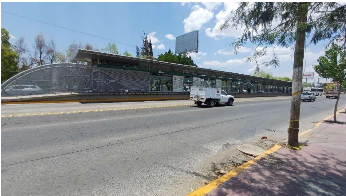
Fotografía 14. Estación intermedia de transferencia “Deportiva”, vista desde la acera en el Blvd. Adolfo López Mateos. Autoría propia (2024).
