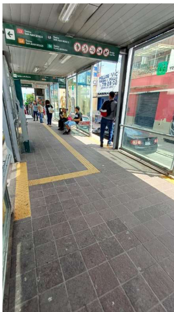
Fotografía 69 y 70. Bahía en el interior de las instalaciones de la estación intermedia “Valverde y Téllez” (superior) y la de la estación intermedia “Industrial” (inferior). Autoría propia (2024).
