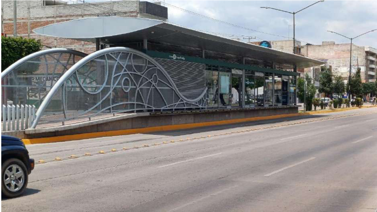
Fotografía 48. Estación intermedia “Parque Hidalgo”, vista desde la acera del Blvd. Adolfo López Mateos. Autoría propia (2024).
