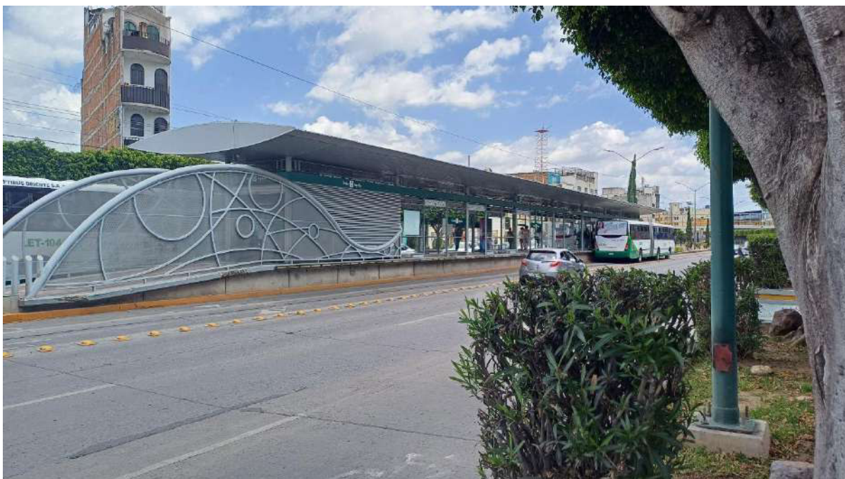
Fotografía 45. Estación intermedia de transferencia “Apolo”, vista desde la acera del Blvd. Adolfo López Mateos. Autoría propia (2024).
