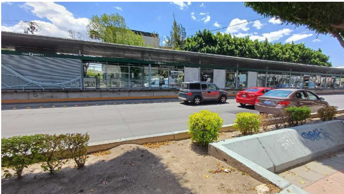
Fotografía 51. Estación intermedia “IMSS T1”, vista desde la acera del Blvd. Adolfo López Mateos. Autoria propia (2024).
