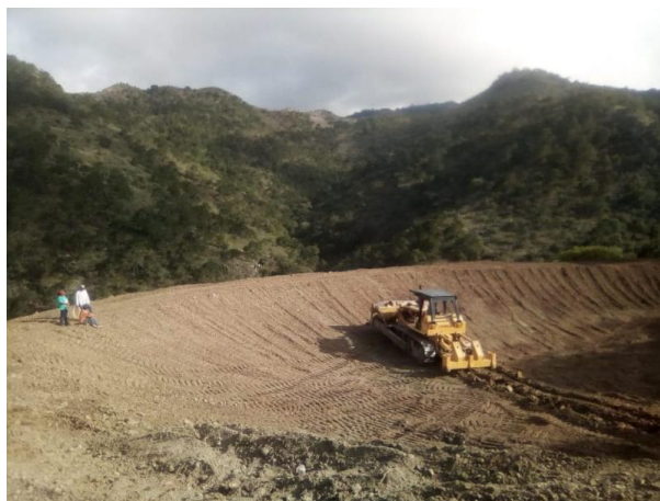
Figura 9. Bordo para captación e infiltración hídrica construido en el municipio de Atarjea como parte del programa “Captemos Agua”. Recuperada de Gobierno del Estado de Guanajuato (2024).
