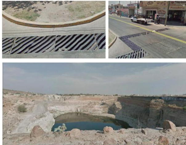
Figura 7. Arriba: Alcantarillas pluviales construidas sobre la avenida Salk. Abajo: Área de captación y recarga en un banco de material en desuso. Recuperadas de Briseño-Ruiz (2017).
