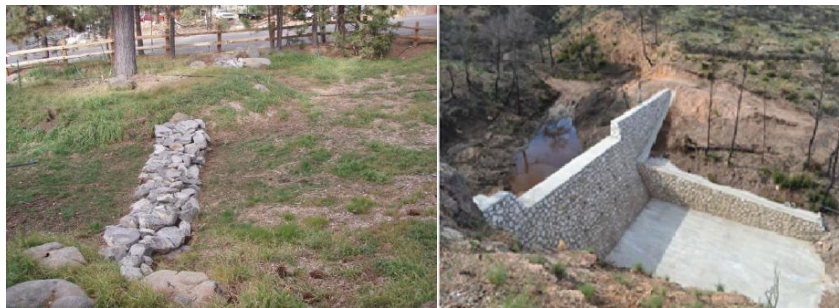
Figura 33. Represas de control para recarga hídrica de distintas dimensiones. Recuperadas de Tahoe Regional Planning Agency (2014) y Lucas-Borja et al. (2021).
