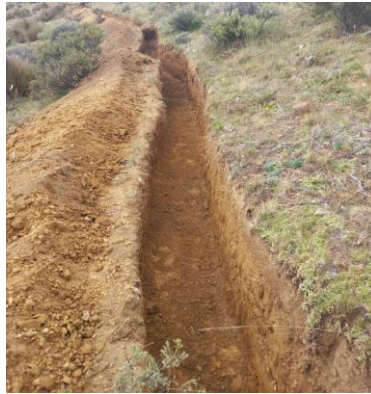
Figura 4. Zanja de infiltración en la provincia de Bolognesi, Perú. Recuperada de Arana (2021).
