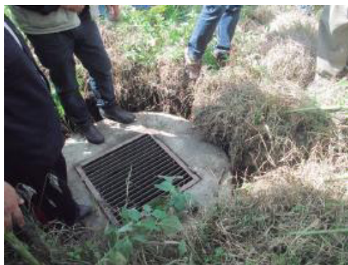
Figura 35. Pozo de absorción construido para captar agua de escorrentía. Recuperada de Ojeda-Olivares et al. (2017).
