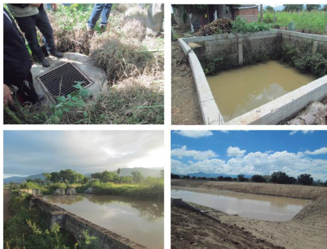
Figura 6. Obras de recarga hídrica construidas por comunidades autóctonas en la subcuenca del Valle de Ocotlán, Oaxaca, México. Arriba izquierda: pozo de absorción circular con reja, arriba derecha:
