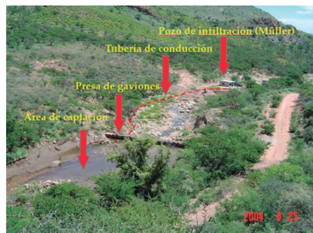
Figura 5. Sistema de recarga hídrica implementado en el río Chuvíscar. Recuperada de Silva-Hidalgo (2017).
