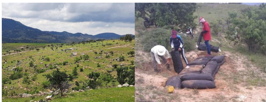
Figura 12. Acciones llevadas a cabo en la comunidad de San José de Otates Sur. Izquierda: tinas ciegas. Derecha: colocación de geocostales para el cabeceo de cárcavas. Recuperadas de Cotas de León, A.C. (2019).
