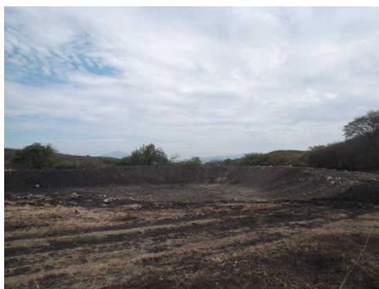
Figura 10. Bordo para captación e infiltración hídrica construido en el municipio de Tarimoro como parte del programa “Captemos Agua”. Recuperada de Gobierno del Estado de Guanajuato (2024).
