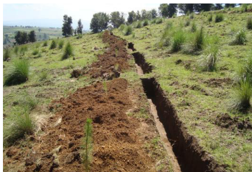
Figura 37. Zanjas de infiltración. Recuperada de CONAFOR (2021).
