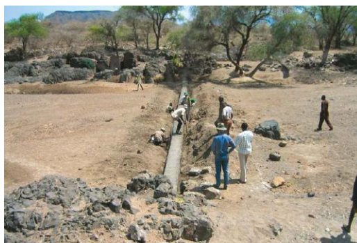
Figura 34. Construcción de una presa subsuperficial. Recuperada de Vétérinaires Sans Frontières (2006).
