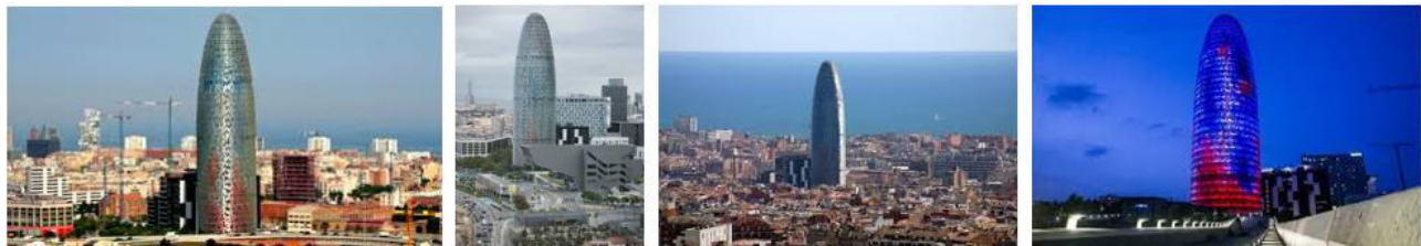
Ilustración 12. Vistas varias de la Torre Agbar.
