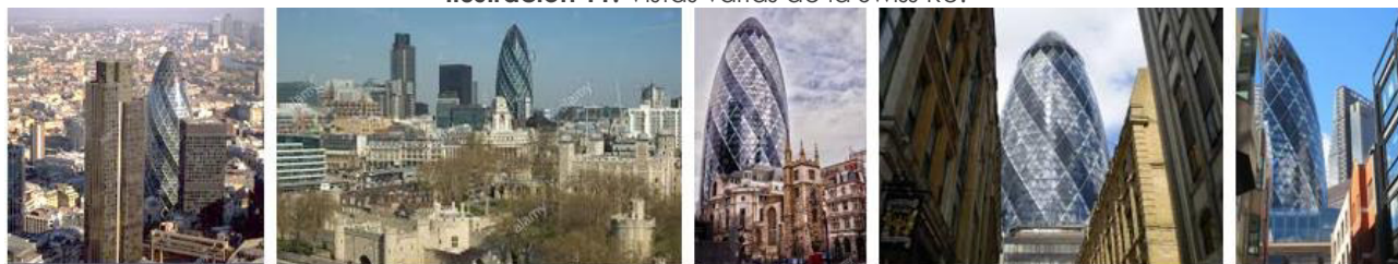
Ilustración 11. Vistas varias de la Swiss Re.
