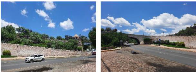
Ilustración 30. Vistas varias del Distribuidor Vial Noria Alta.
