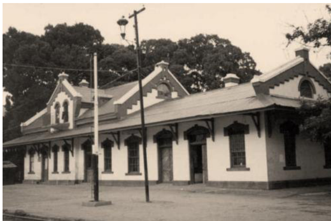
Ilustración 42. Edificio de la Ex Estación del Ferrocarril.
