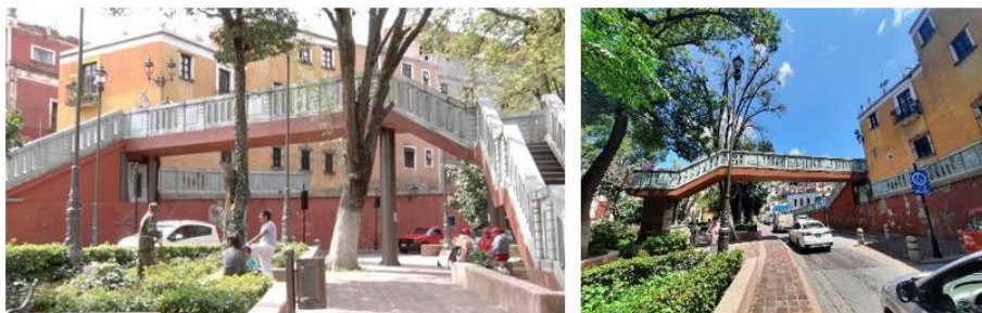
Ilustración 35. Vistas varias del Puente Peatonal de Embajadoras.
