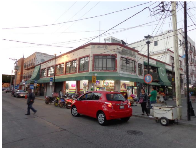
Ilustración 79.-Imagen donde se aprecia la gran cantidad de cableados y postes existentes en el centro histórico; lo cual denigra el patrimonio existente en esta área, además de afectar el correcto flujo de peatones sobre las banquetas. Fuente: Amezcua, 2017
