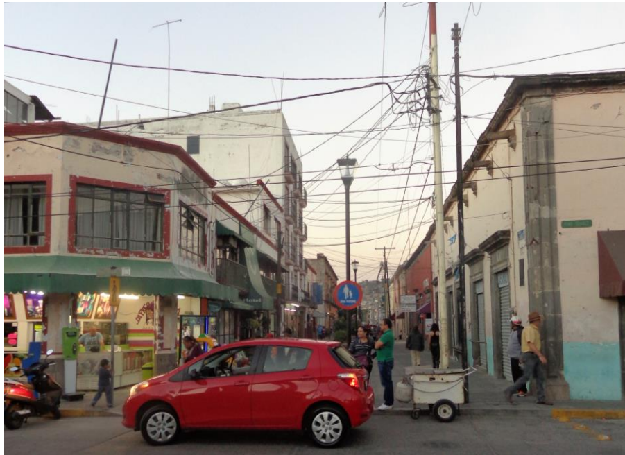
Ilustración 86.-Imagen de la calle Benito Juárez, donde se aprecian las grotescas modificaciones a antiguas casonas de los siglos XVIII y XIX, a fin de convertirlas en locales comerciales; lo cual indica claramente, el nulo respeto que existe por parte de la población del sitio hacia su patrimonio. Fuente: Amezcua, 2017
