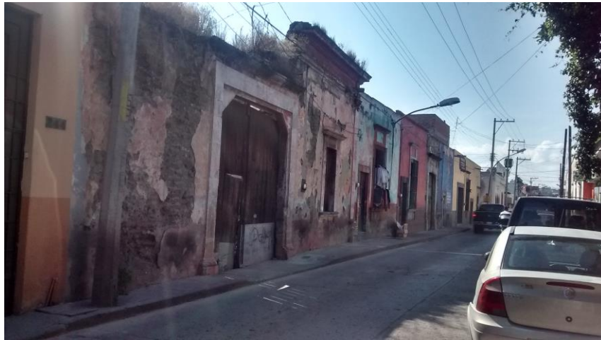
Ilustración 84.-Imagen de la calle Francisco I. Madero, donde se pueden apreciar las antiguas casonas del siglo XVIII inmersas en un franco proceso destructivo, el cual se debe frenar a la brevedad. Fuente: Amezcua, 2017
