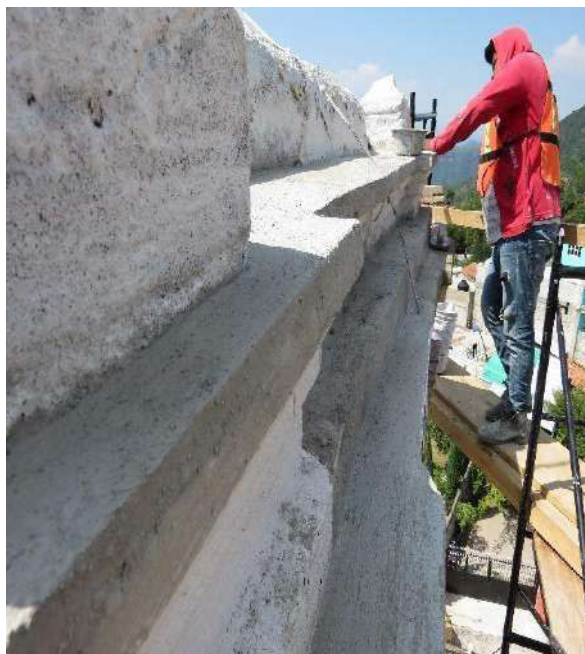
Fotografías 216 y 217. Reintegración de entortados en superficies planas de nave.
