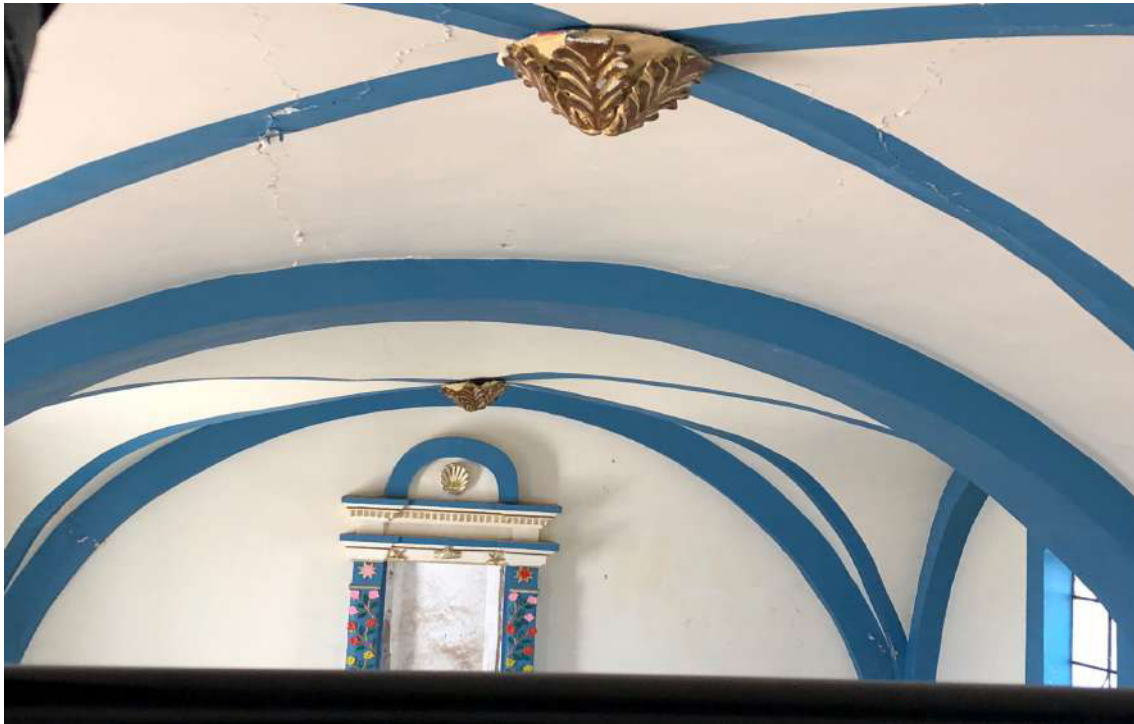
Fotografía 263: Se observan las fisuras en aplanado de bóveda.
