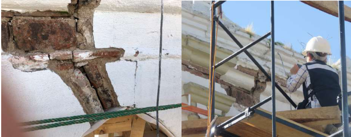
Fotografía 123. Se observa grieta estructural en arco de torre. Fotografía 124. Daño en cornisa de torre.
