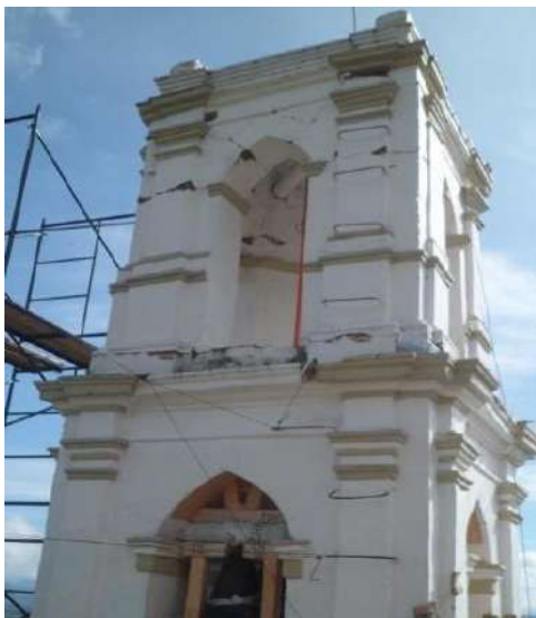
Fotografías 119 y 120. Vistas de las grietas en interior y exterior de la torre.
