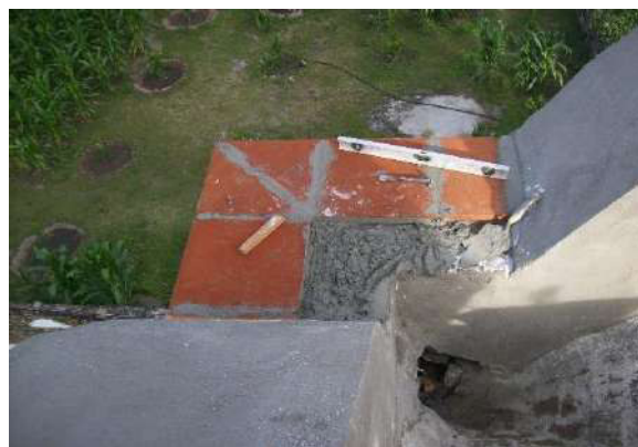
Fotografías 244 y 245. Reintegración de entortados de pretiles en cubiertas.
