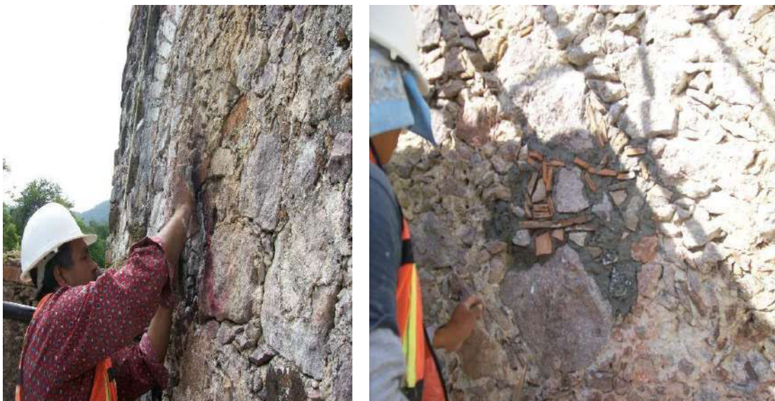
Fotografías 235 y 236. Tapado de machinales.
