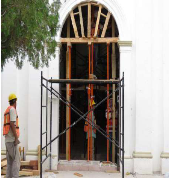
Fotografía 159 y 160. Apuntalamiento mediante la nivelación de gatos hidráulicos.
