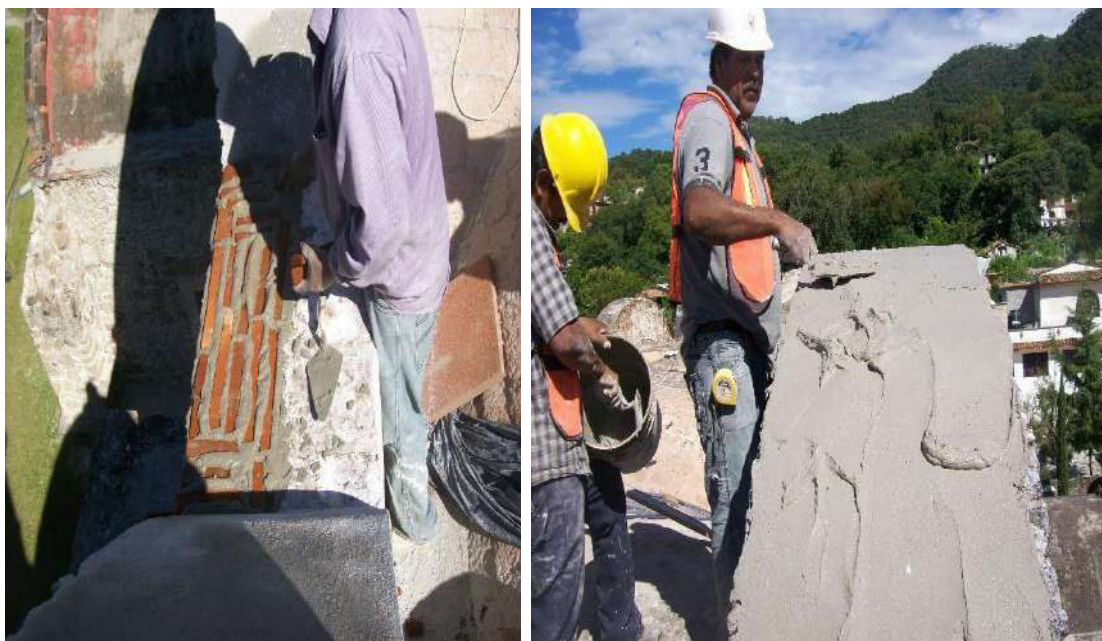
Fotografías 214 y 215. Reintegración de entortados en cornisas.
