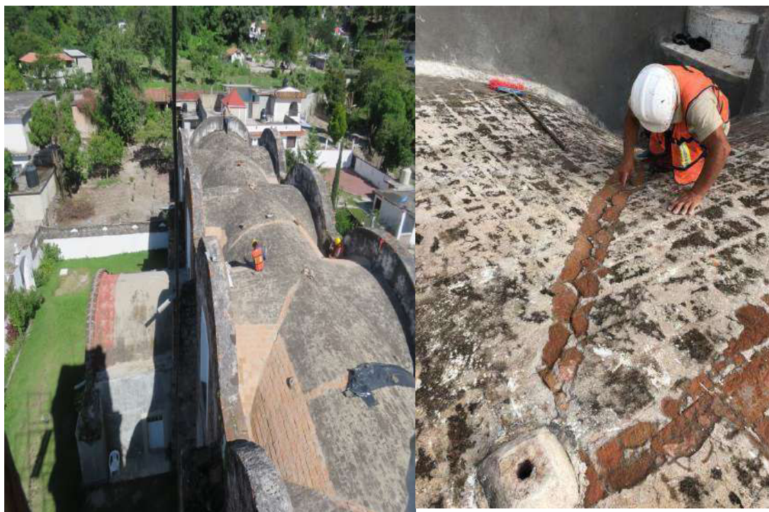
Fotografías 134 y 135. Eliminación de planilla para revisión de daños en bóvedas.
