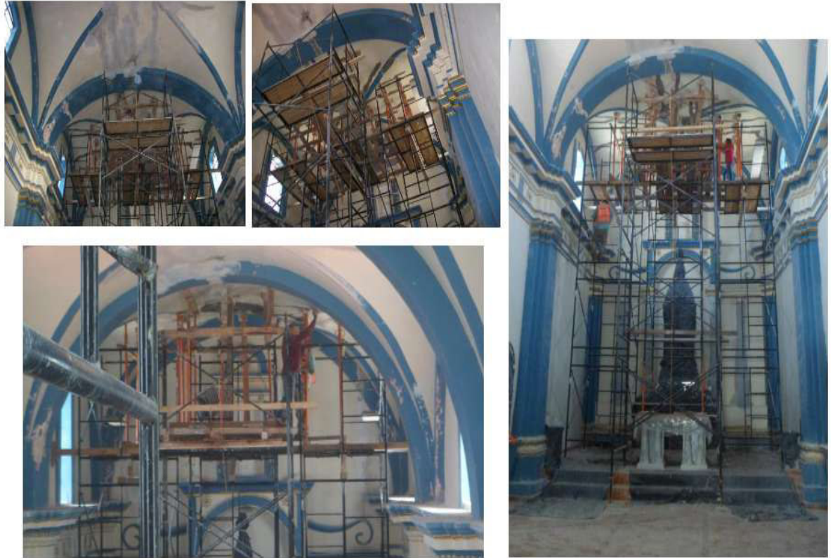
Fotografía 264: colocación de apuntalamiento en bóveda de presbiterio.
