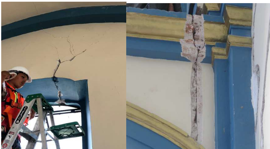
Fotografía 129. Grieta estructural en área de coro y sotocóro.
