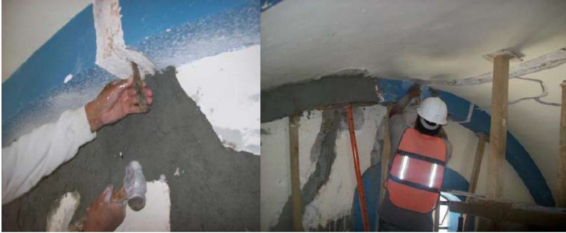
Fotografía 181 y 182. Aseguramiento de piezas mediante la integración de calzas de madera.
