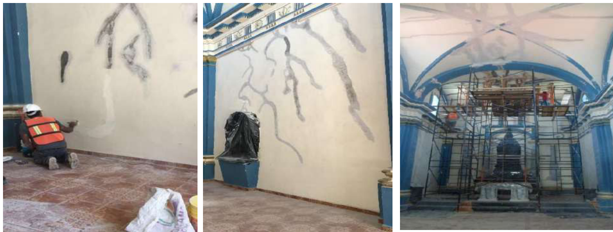
Fotografías 253-255. Reintegración de enlucidos al interior de la nave.
