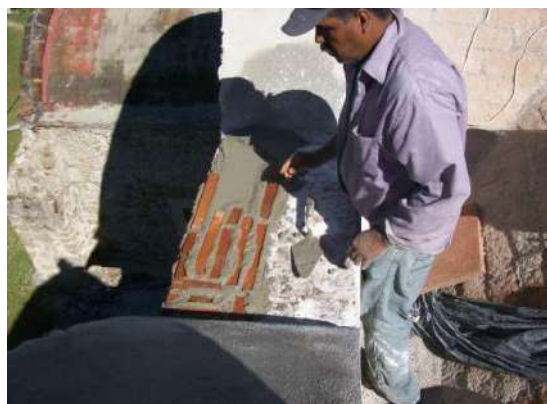
Fotografías 244 y 245. Reintegración de entortados de pretiles en cubiertas.
