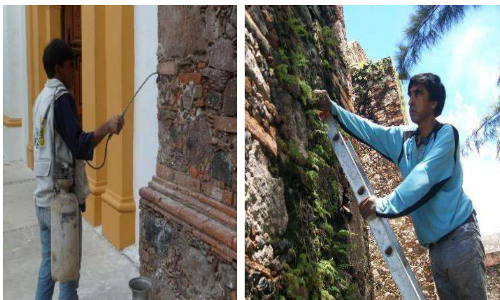
Fotografía 188. Fumigación al exterior de nave, sacristía y capilla; en cubiertas, muros y contrafuertes y cuerpos de torre.
