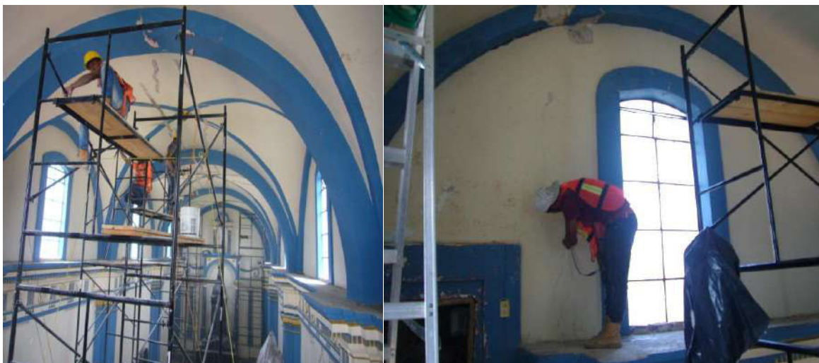
Fotografías 156 y 157. Colocación del sistema de andamiaje.
