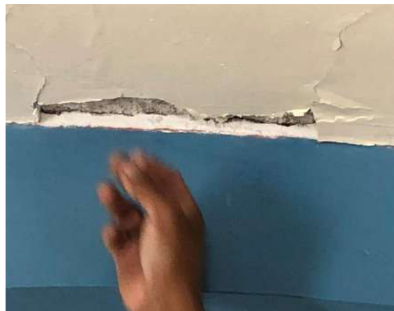
Fotografía 93. Grietas y fisuras en Aplastado.
