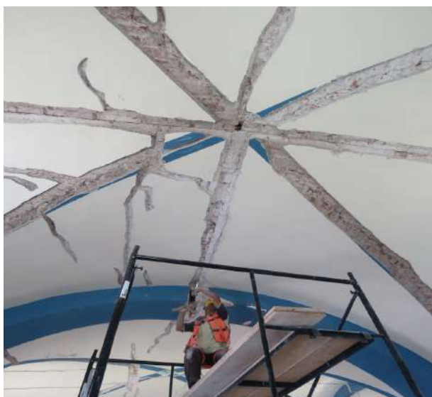
Fotografía 140. Calas de prospección en bóveda.
