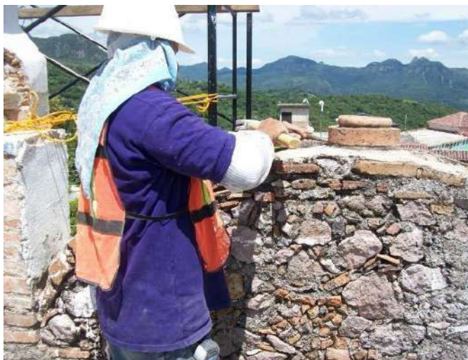
Fotografía 167. Liberación de aplanado en grietas al exterior de la nave, en la imagen se presenta también el retiro del aplanado en los pretilos desprendidos en fachada principal.
