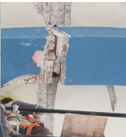
Fotografía 141. Grieta estructural en arco.
