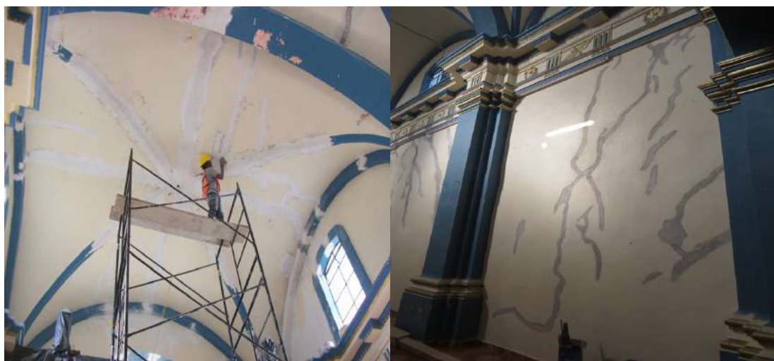
Fotografías 186 y 187. Reintegración de aplanado al interior.
