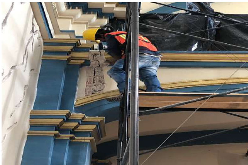
Fotografía 128. Grieta estructural en cornisa y muro de coro.
