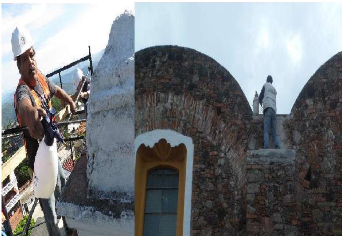
Fotografías 189. Retiro de flora parasitaria, lavado y fumigación.
