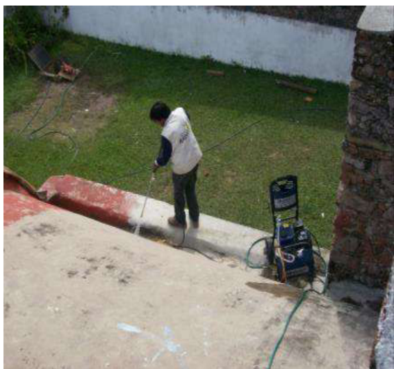
Fotografía 192- 193. Fumigación al exterior de nave, sacristía y capilla; en cubiertas, muros y contrafuertes y cuerpos de torre.
