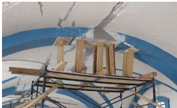
Fotografía 162: Cercha terminada para apuntalamiento de arco toral.
