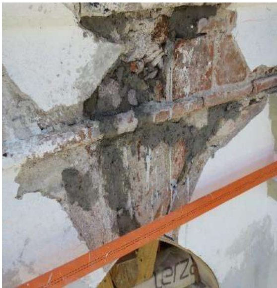
Fotografías 175 y 176: Luego de la limpieza de grieta, se realizó el rajueleo en junta disgregada o fracturada, las lajas de piedra se asentaron con mortero cal- arena.
