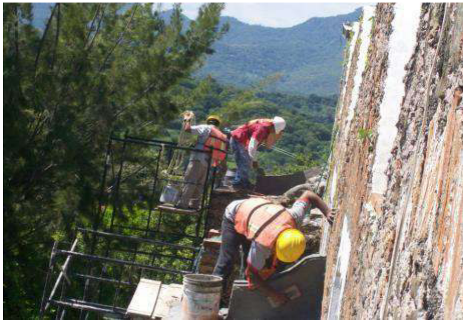
Fotografía 223. Construcción de cajillo sobre contrafuerte.
