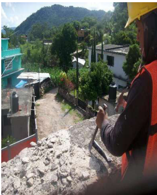
Fotografías 200. Liberación de plantillas en pretiles.
