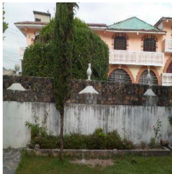
Fotografías 233 y 234. Elaboración y remoldeo de esferas en barda atrial.
