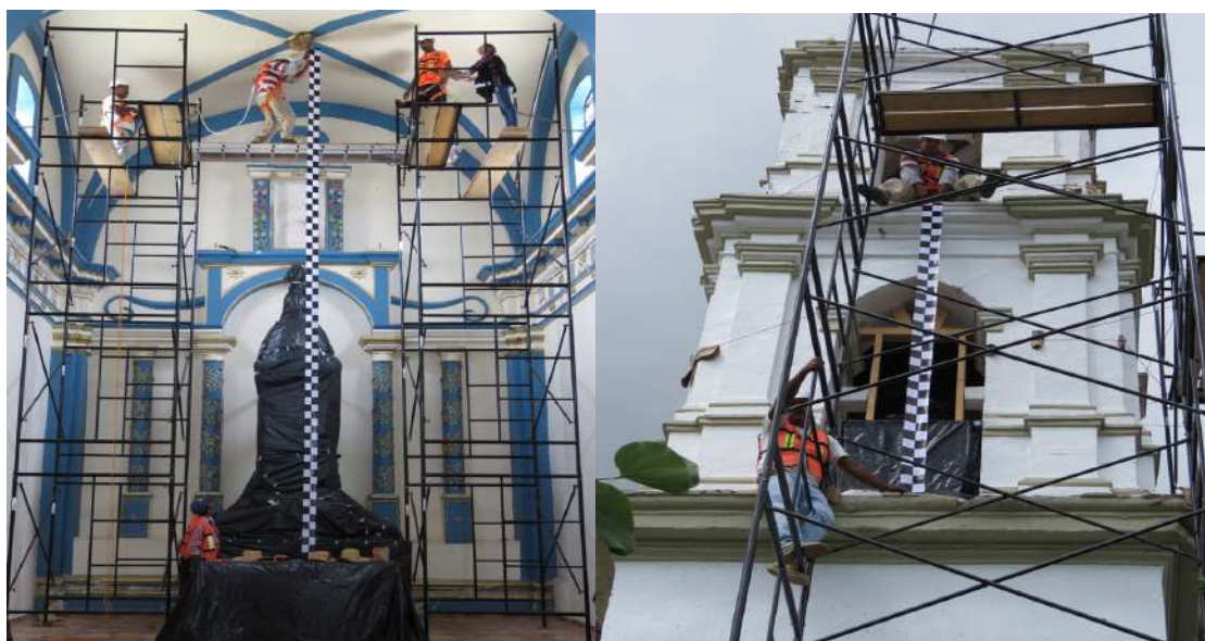
Fotografías 40 y 41: Levantamiento arquitectónico en área de presbiterio y torre.
