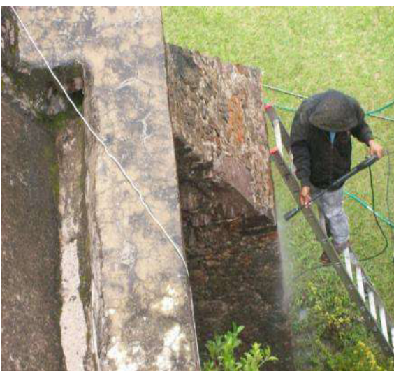
Fotografía 192- 193. Fumigación al exterior de nave, sacristía y capilla; en cubiertas, muros y contrafuertes y cuerpos de torre.
