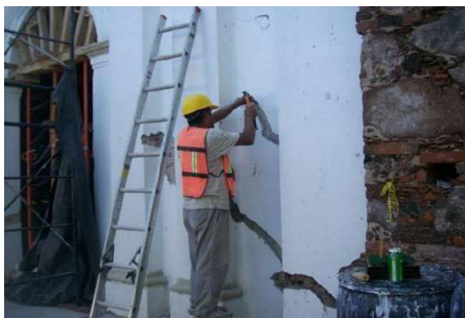
Fotografía 168: Liberación de aplanados en fachada principal para el tratamiento de las fisuras.
