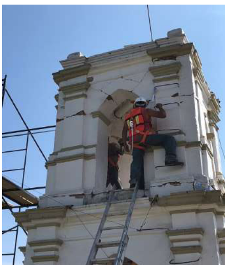
Fotografías 121 y 122. Se pueden ver los daños al exterior y al interior de los cuerpos de torre.
