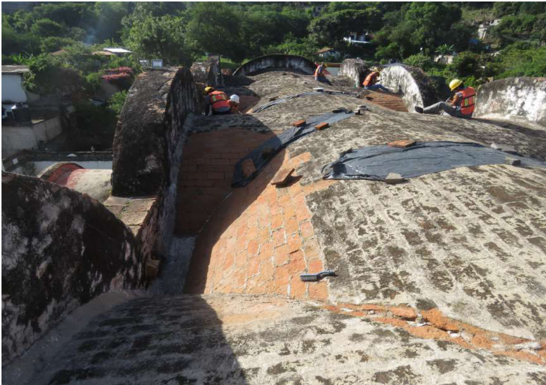
Fotografía 164. Retiro de aplanado en bóveda.
