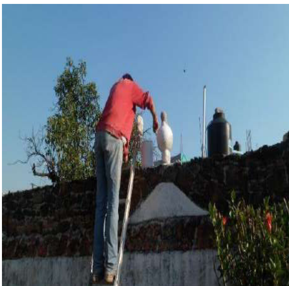
Fotografías 233 y 234. Elaboración y remoldeo de esferas en barda atrial.
