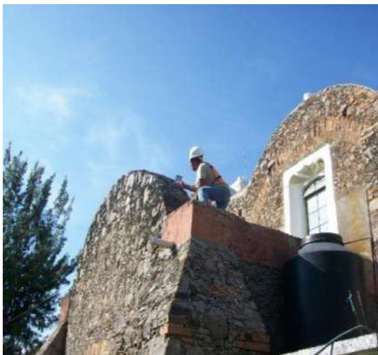
Fotografía 192- 193. Fumigación al exterior de nave, sacristía y capilla; en cubiertas, muros y contrafuertes y cuerpos de torre.
