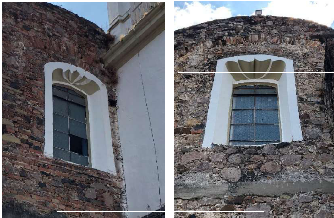
Fotografía 58 y 59. Se pueden observar los sistemas constructivos de muros y vanos. Así como su estado de conservación, e intervenciones recientes.
