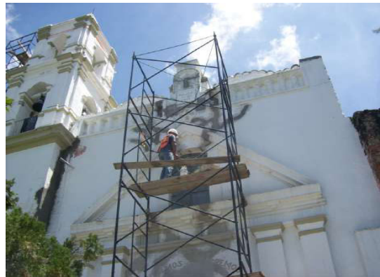
Fotografía 183: Colocación de aplanado en zonas intervenidas en fachada principal.
