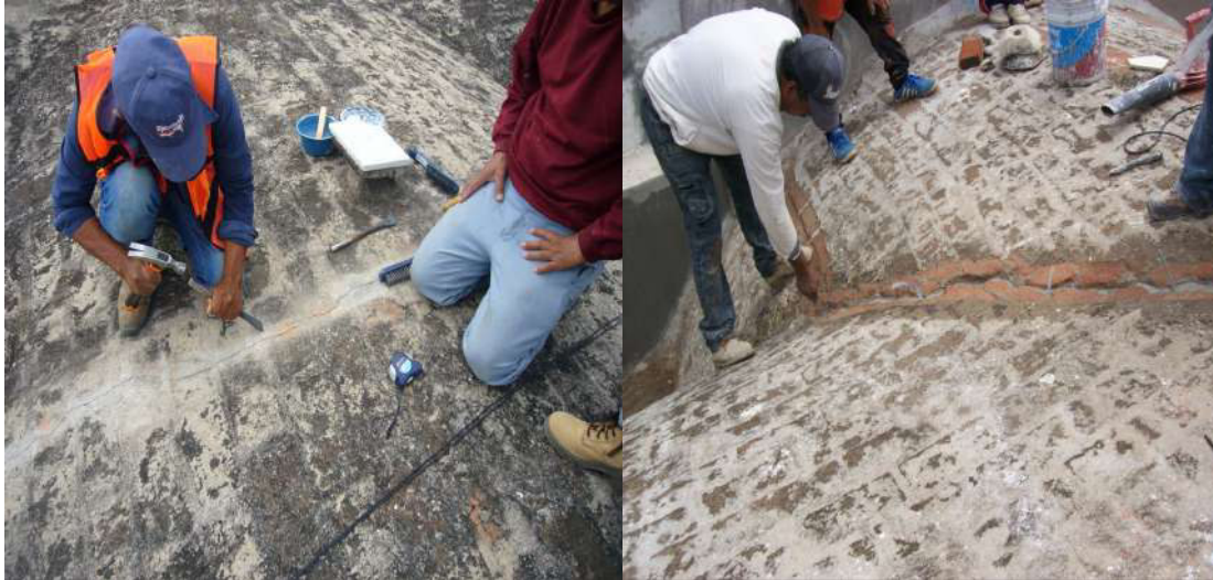
Fotografía 266 y 267: eliminación de entortado para inspección de grieta.
