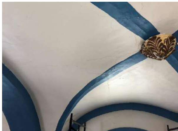
Fotografía 94. Grietas y fisuras en crucerías.
