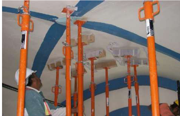
Fotografía 161: Proceso de estructuración de apuntalamiento en cúpula de nave.
