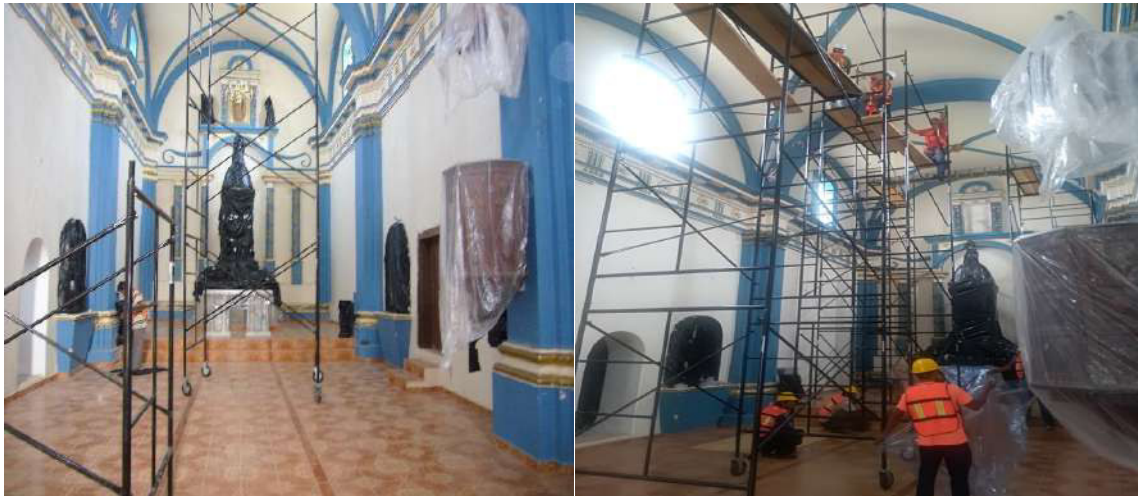
Fotografías 152 y 153. Protección de elementos ornamentales y colocación de andamiaje.
