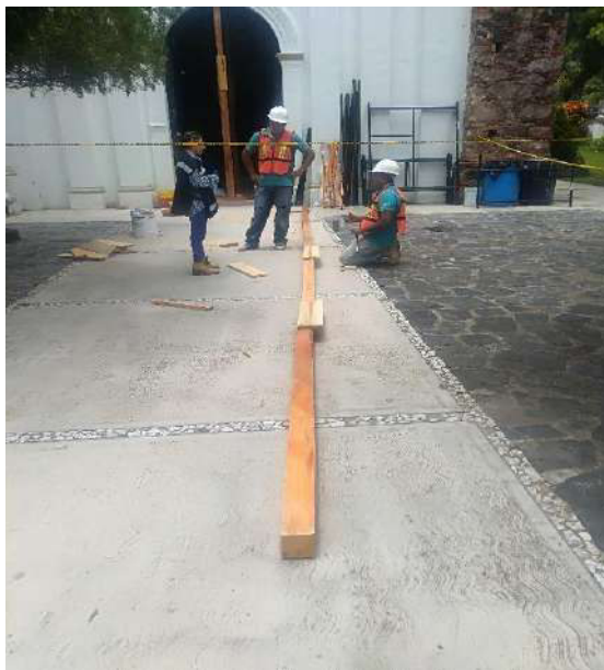
Fotografía 154-155: Trazo y corte de las partes del apuntalamiento en sitio.
