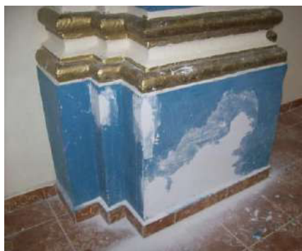
Fotografías 250-252. Colocación de enlucido en muros con intervenciones.
