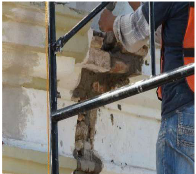
Fotografías 175 y 176: Luego de la limpieza de grieta, se realizó el rajueleo en junta disgregada o fracturada, las lajas de piedra se asentaron con mortero cal- arena.
