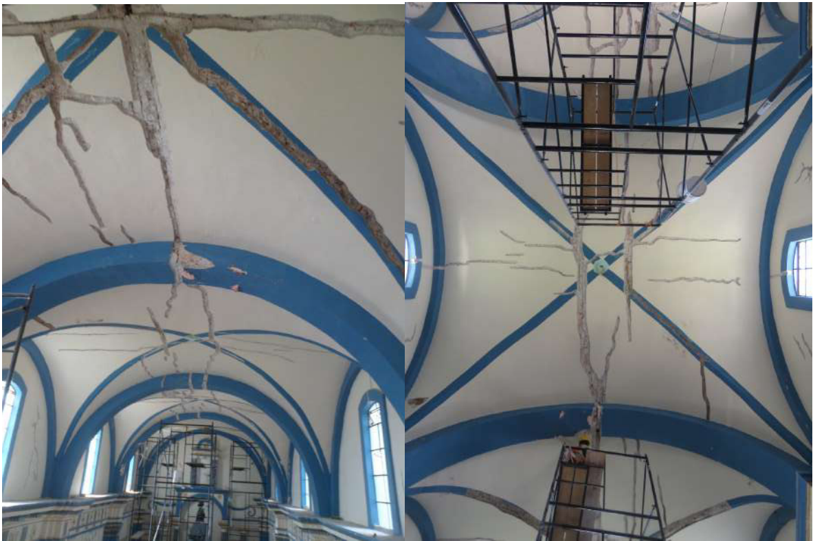
Fotografías 136 y 137. inspección de grietas y fisuras en intrádos de bóveda.
