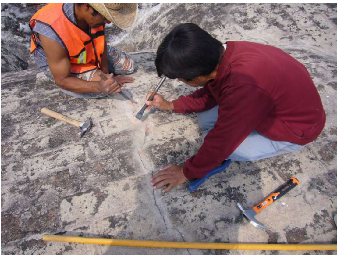
Fotografía 265. Cala de inspección en grieta de bóveda.
