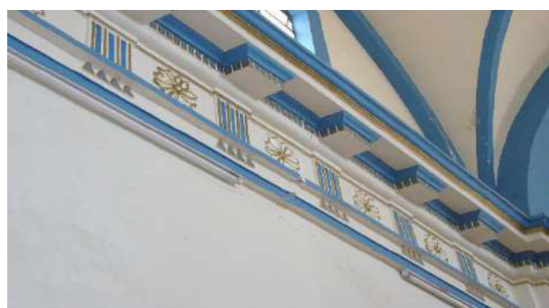
Fotografía 81. Imagen de las luminarias aparentes e improvisadas en el entablamento. Fotografía 82. Imagen de elementos arquitectónicos que conforman el entablamento: metopas, triglifos, régulas, gotas, ménsulas y cornisamento corrido.
