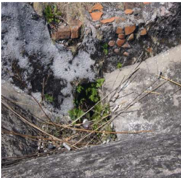
Fotografía 52. Bajadas de agua completamente tapadas.
