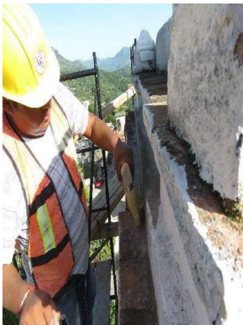
Fotografías 216 y 217. Reintegración de entortados en superficies planas de nave.
