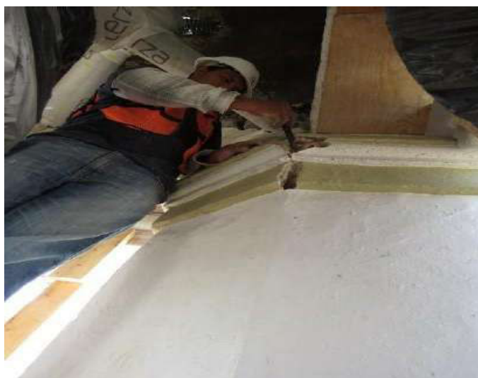
Fotografía 169. Liberación de aplanado al interior de la torre campanario, siguiendo la trayectoria de las grietas identificadas.
