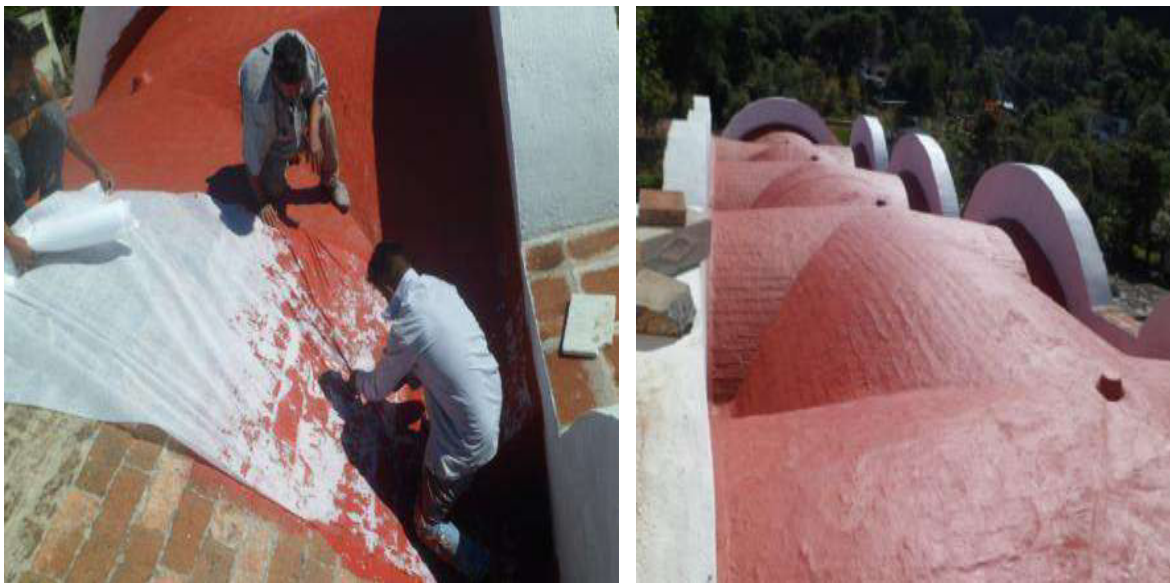
Fotografías 220 y 221. Impermeabilización en bóvedas.
