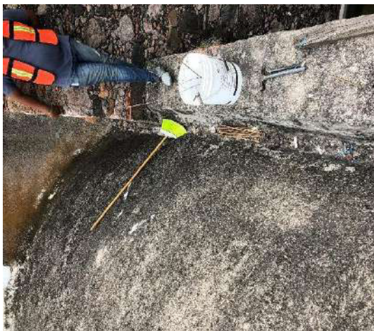
Fotografías 242 y 243. Liberación y reintegración de chaflanes en cubiertas de capilla y sacristía.
