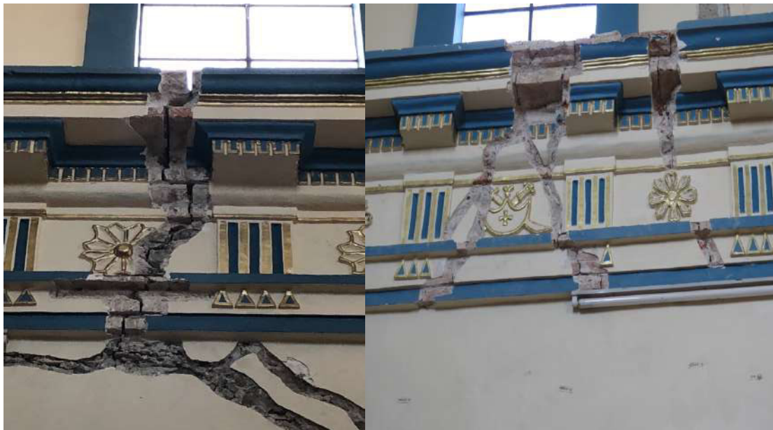
Fotografía 130. Grietas estructurales en áreas de cornisas.
