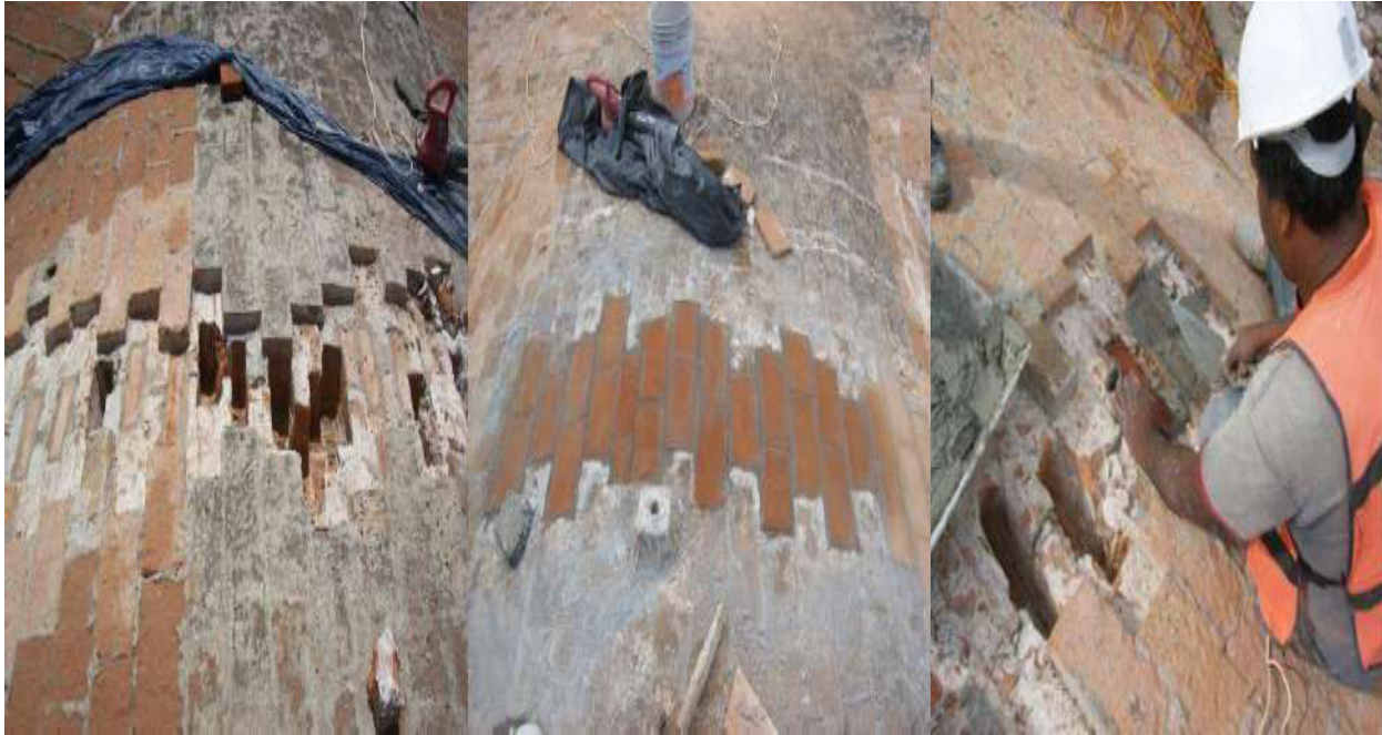
Fotografías 179-180. Consolidación de cúpula mediante cosido de grieta trascendente y colocación de grapas de tabique en áreas fracturadas para interrumpir el desarrollo de la grieta.
