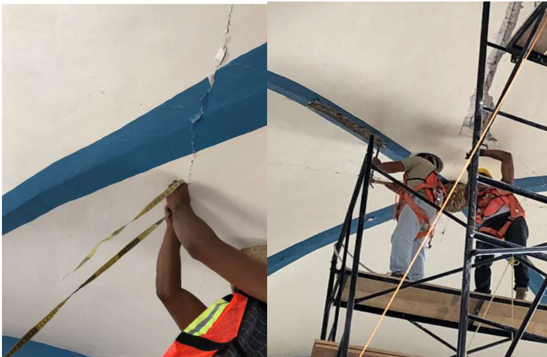
Fotografía 142 y 143. Inspección de grietas en bóvedas.
