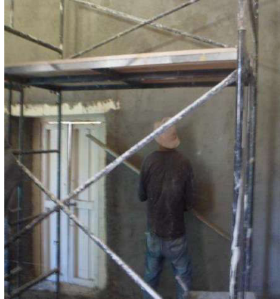
Fotografías 205 y 206. Liberación y reintegración de aplados al interior de capilla y sacristía.
