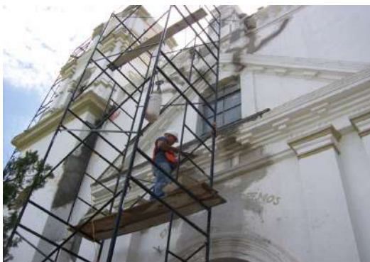
Fotografías 184 y 185. Reintegración de aplanado únicamente en las áreas afectadas luego de su tratamiento.
