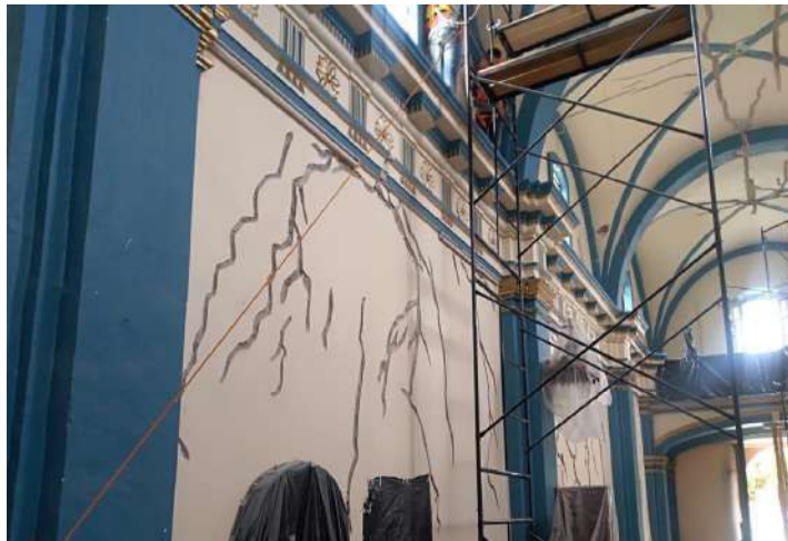
Fotografía 163: Liberación de aplanado en fisuras al interior de la nave, previo sondeo mediante calas de inspección.
