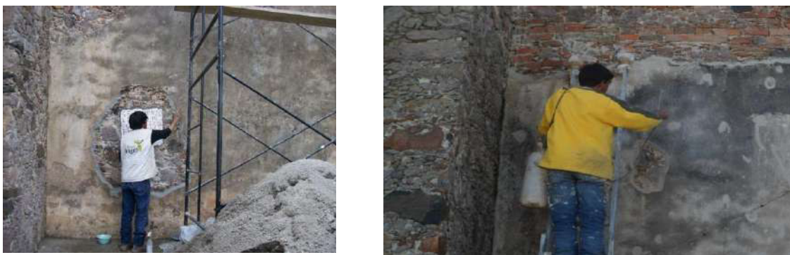
Fotografías 237-238. Ribeteo en aplanados antiguos en muros laterales al exterior de nave.
