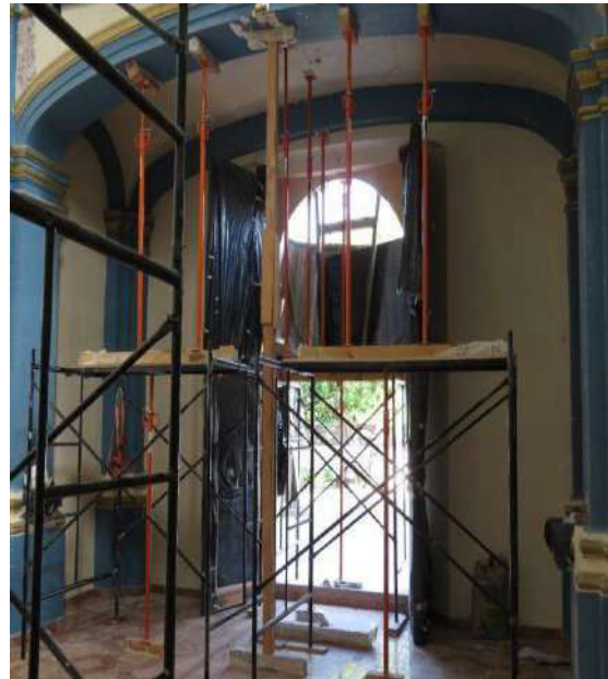
Fotografía 159 y 160. Apuntalamiento mediante la nivelación de gatos hidráulicos.
