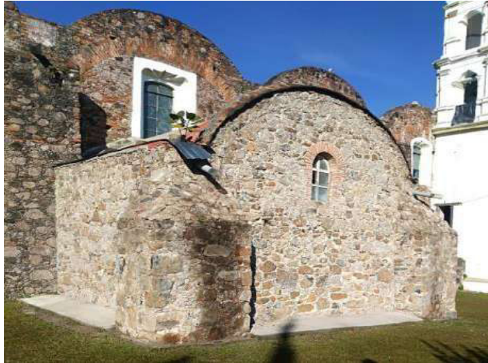
Fotografía 210. Liberación de aplanado de cemento en capilla.
