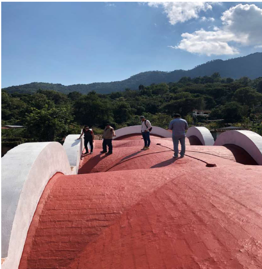
Fotografía 222. Impermeabilización en cubiertas.
