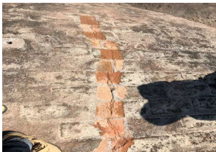
Fotografía 126. Grieta estructural en área de bóveda.
