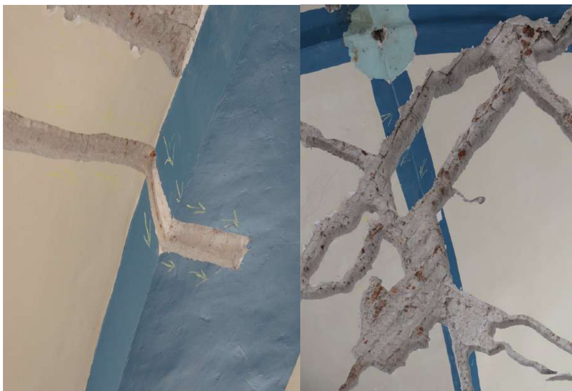
Fotografía 144 y 145. Inspección de grieta en arco formero y bóveda.
