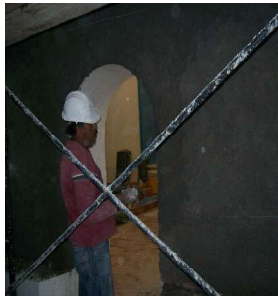
Fotografía 204. Colocación de aplanado en capilla.
