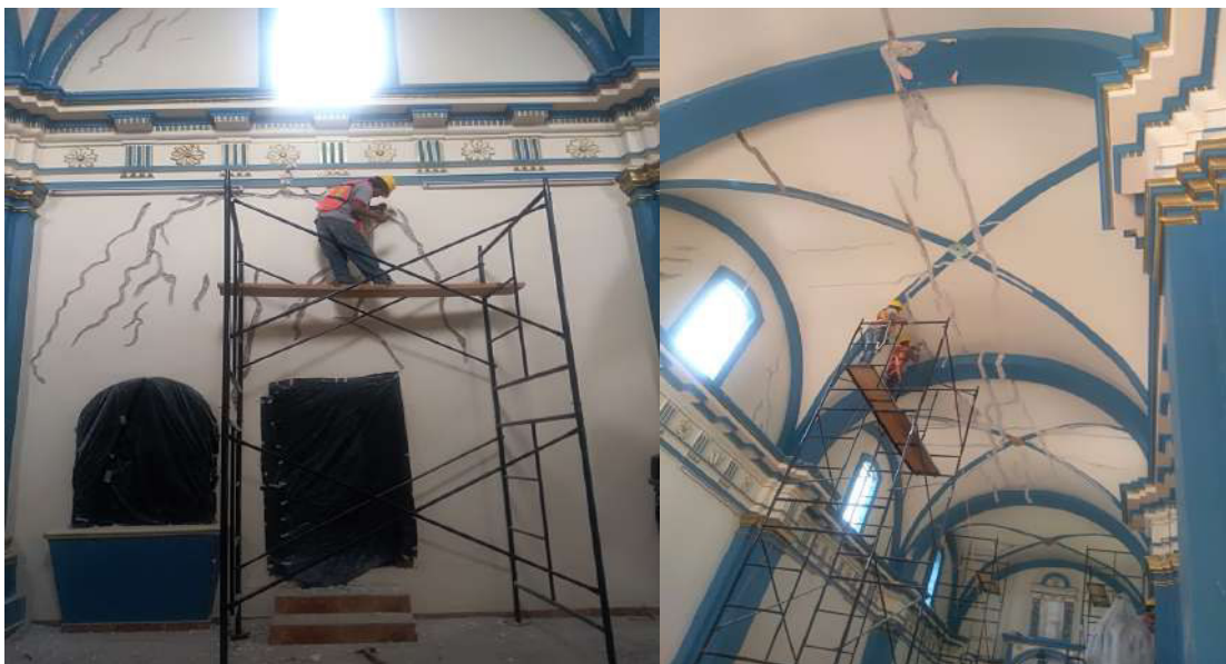
Fotografías 165 y 166. Inspección en muros y cubiertas por medio de calas
