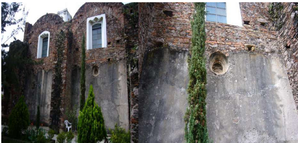
Fotografía 67. Estado de conservación de aplanado original.
