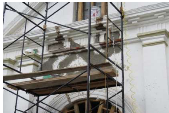
Fotografías 184 y 185. Reintegración de aplanado únicamente en las áreas afectadas luego de su tratamiento.
