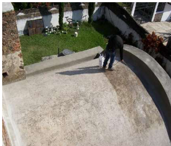
Fotografías 242 y 243. Liberación y reintegración de chaflanes en cubiertas de capilla y sacristía.
