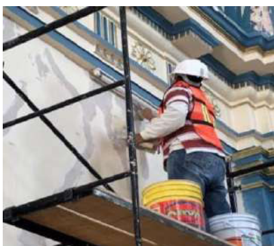
Fotografías 250-252. Colocación de enlucido en muros con intervenciones.
