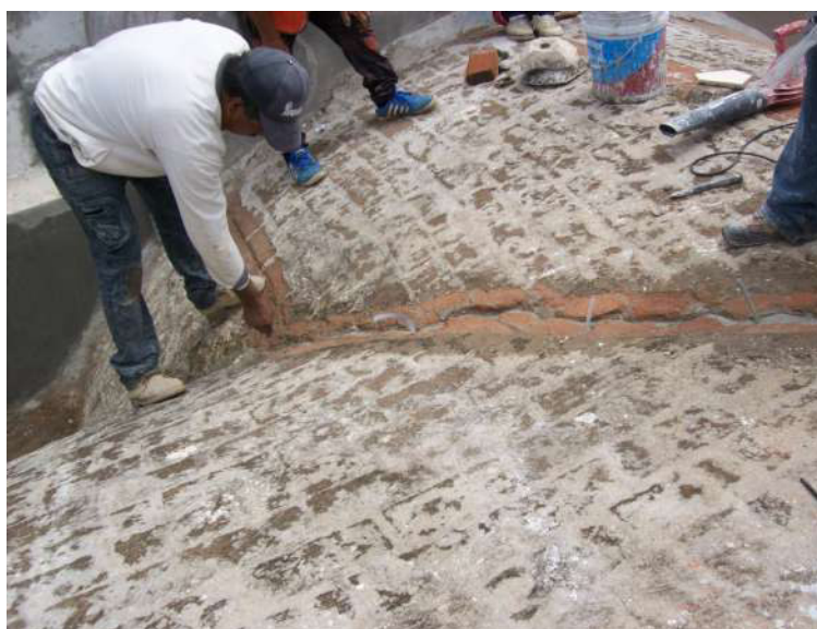
Fotografía 127. Grieta estructural en crujería.
