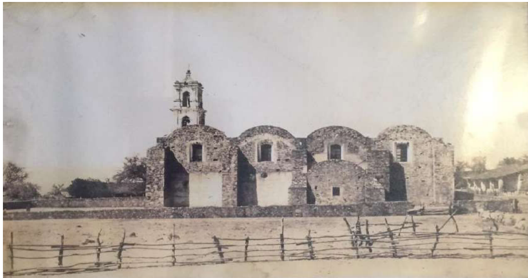
Fotografía 27: Vista frontal de la fachada lateral este. Se aprecia la espadana original y las cubiertas abovedadas de las naves. 82
