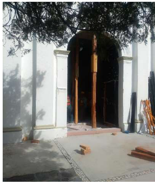
Fotografía 154-155: Trazo y corte de las partes del apuntalamiento en sitio.
