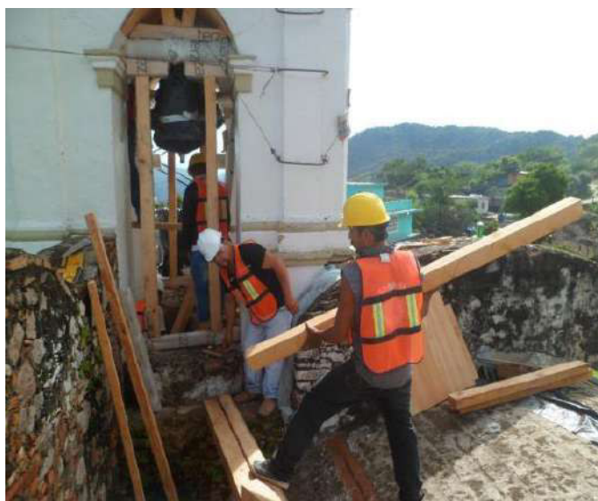
Fotografía 158: Habilitado del cuerpo del apuntalamiento (vigas madrina, de arrastre y pies derechos).
