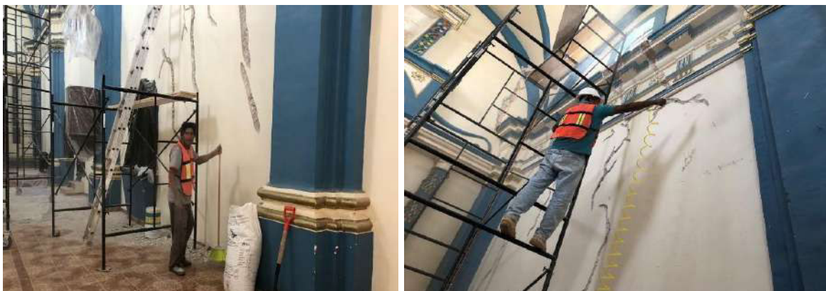
Fotografías 171-172: Limpieza húmeda con agua-alcohol y aspersión de agua cal y consolidación de cúpula.
