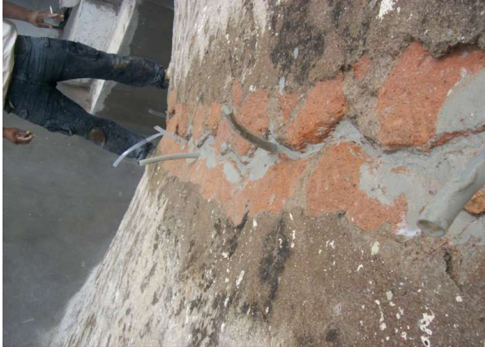
Fotografía 268: Colocación de puertos para inyección.
