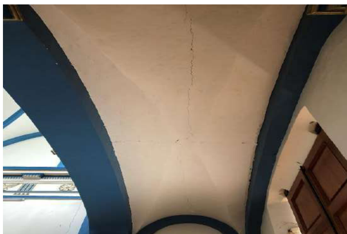
Fotografía 89. Detalle de grieta en bóveda.
