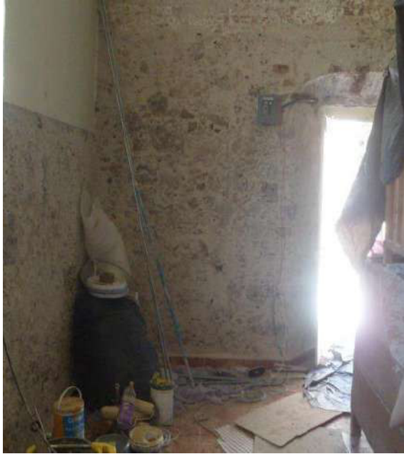
Fotografías 205 y 206. Liberación y reintegración de aplados al interior de capilla y sacristía.
