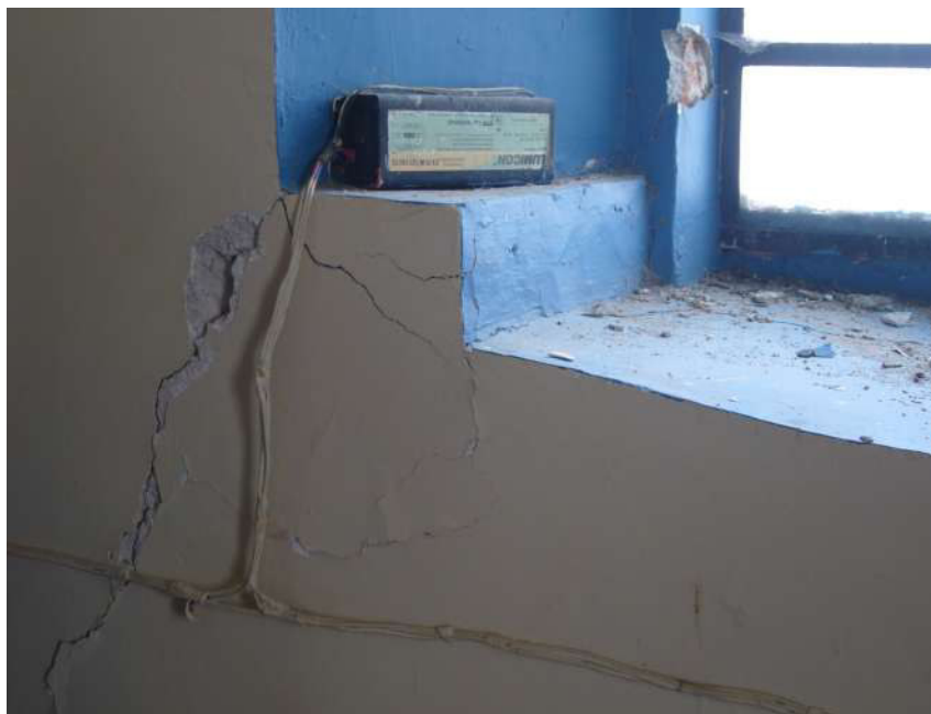
Fotografía 131. Grieta estructural en muro de coro.
