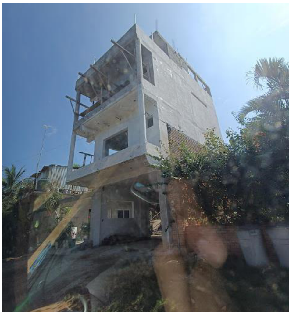
Ilustración 20 Construcción que revela la falta a las reglas locales. Fotografía propia. Capturada 5 de julio de 2022.
