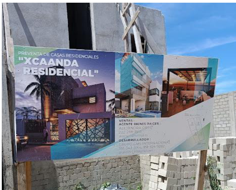
Ilustración 18 Oferta inmobiliaria en construcción en proceso. Fotografía propia. Capturada 10 de julio de 2022.
