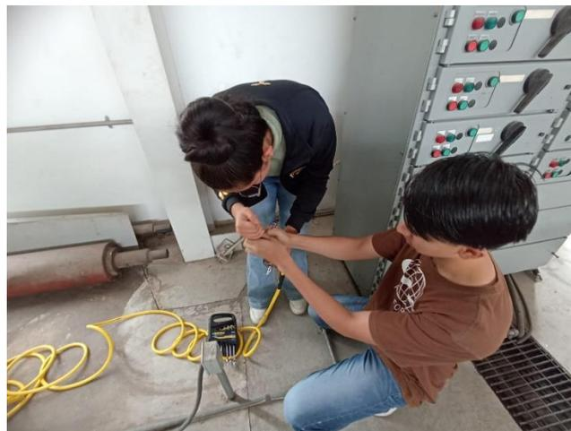
*Figura 17. Conexión de aire comprimido del MQL a la línea principal*
