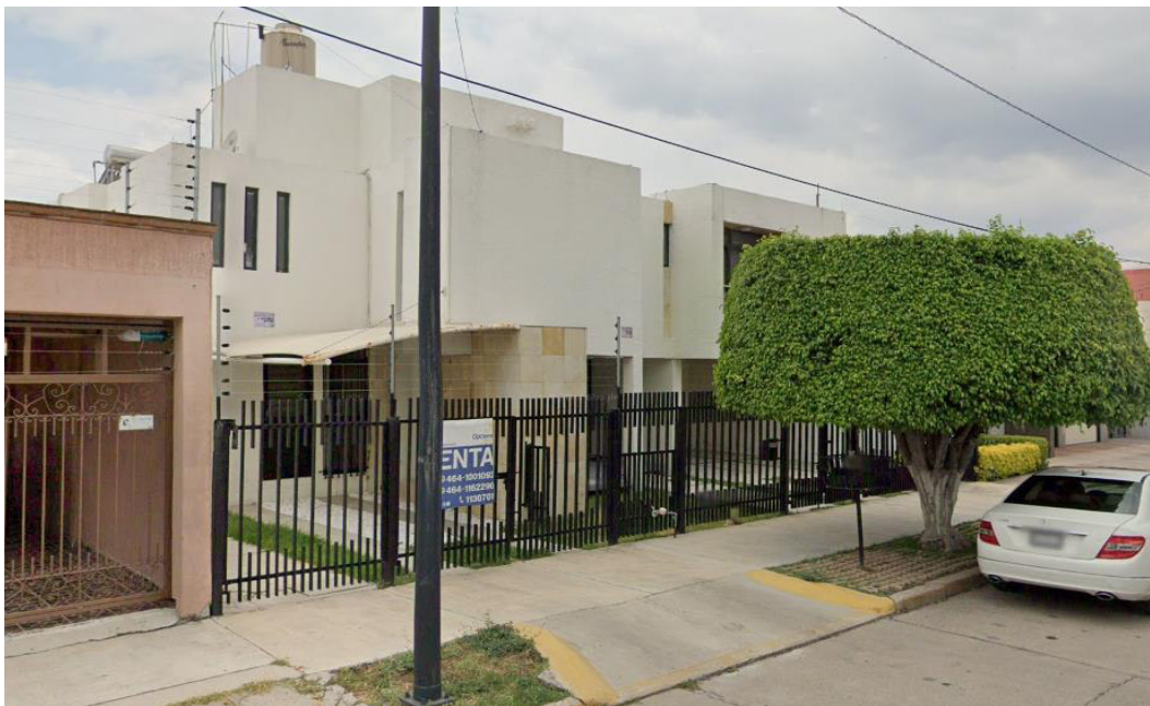
FACHADA PRINCIPAL SOBRE LA CALLE PÁNUCO.
