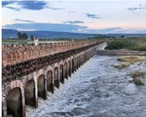
FOTOGRAFÍA 24: Compuertas de la presa nueva (Santa Efigenia) en Jalpa de Cánovas (Las Colonias) (2017). Toma propia.
