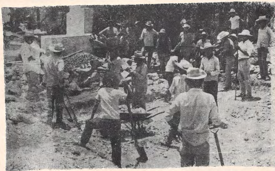
CONSTRUCCION DE ALJIBES
