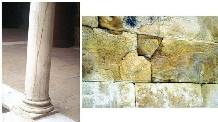
Figura 3. Deterioro de materiales pétreos debido a cambios climáticos [9].
