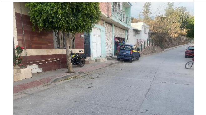
Fig. 3. Fotografía de casas construidas en calle pavimentada Archivo personal
