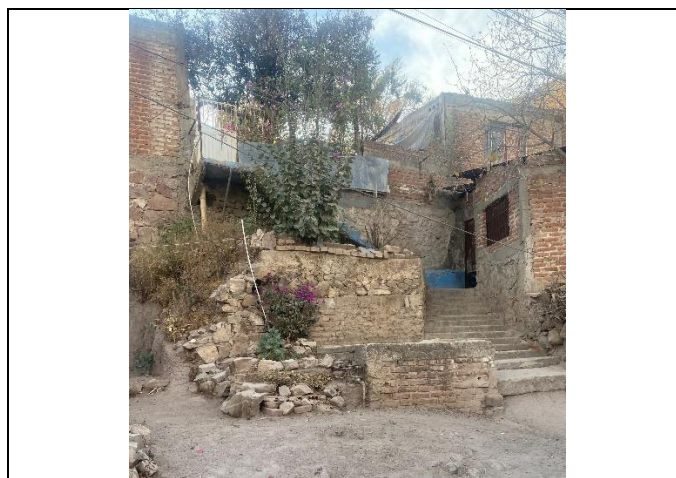
Fig. 4. Fotografía de casa en obra negra en calle de terracería Archivo personal
