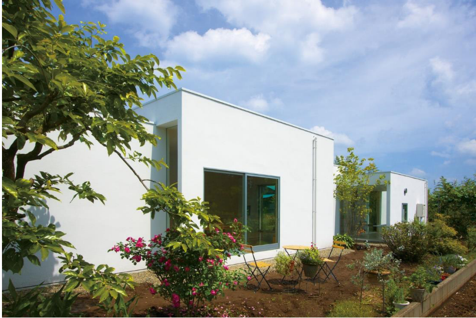
Ilustración 75. Casa en Sakura / Yamazaki Kentaro Design Workshop Vista del exterior. Fuente: https://www.archdaily.mx/mx/02-363547/casa-en-sakura-yamazaki-kentaro-design-workshop?ad_source=myad_bookmarks&ad_medium=bookmark-open .
