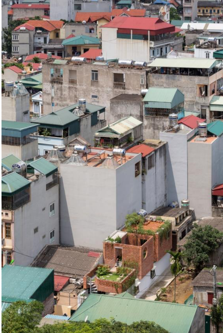
Ilustración 106. Contexto inmediato de Casa VH. Fuente: https://www.archdaily.mx/mx/958295/casa-vh-oddo-architects?ad_source=myad_bookmarks&ad_medium=bookmark-open
